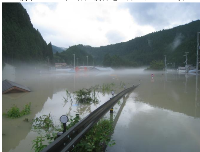
浸水ピーク時：弁天橋付近 9月4日16:30 頃
