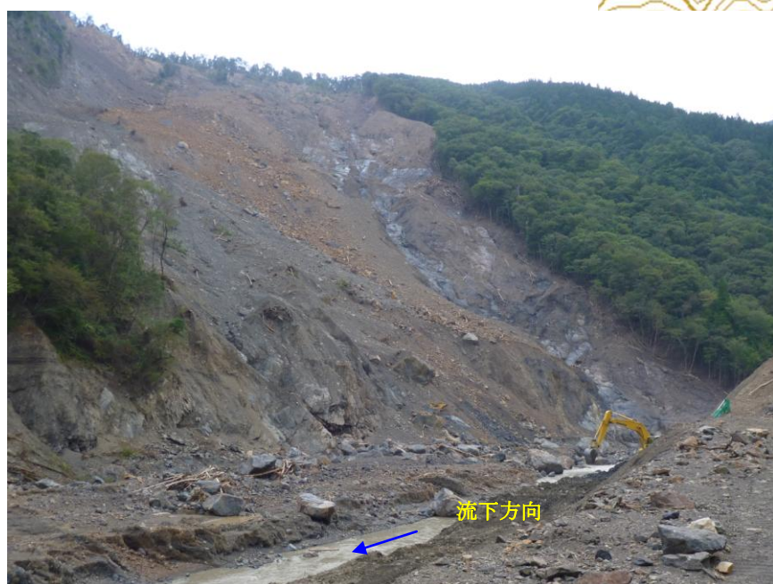
崩壊地を望む（長殿北）
