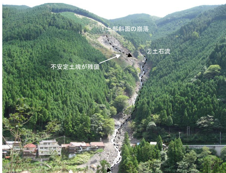
対岸よりの崩壊地全貌（鍛冶屋谷）
