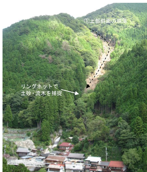
対岸よりの崩壊地全貌（柳谷）
