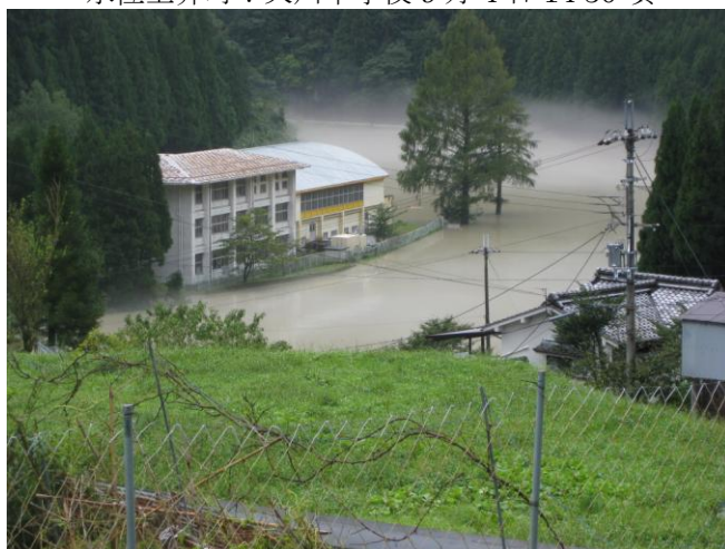
水位上昇時：天川中学校 9月4日14:30 頃
