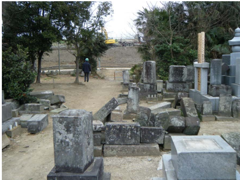
7) 現場近くの墓地。墓石の倒壊。
