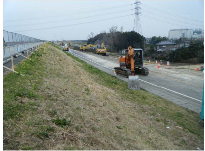
2) 復旧作業の様子
