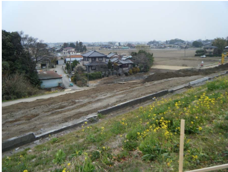
1) すでに復旧作業に入っており、 アスファルト等は除去された状態。
