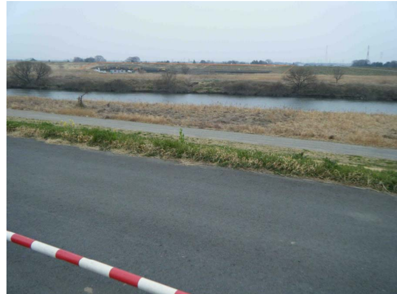
4) 左岸(対岸)遠景
