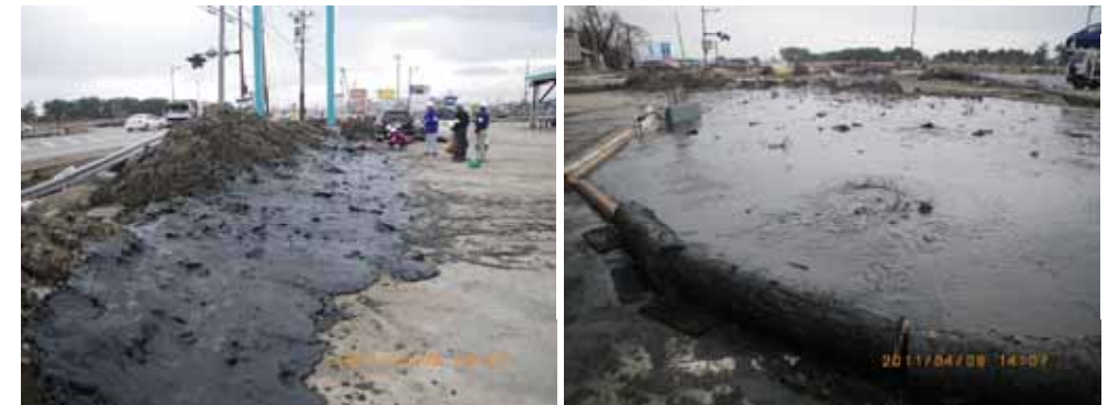
店舗内に堆積していた泥を道路脇に集積している様子。 店舗内の泥土は含水比が高く、濃褐色を呈していた。
