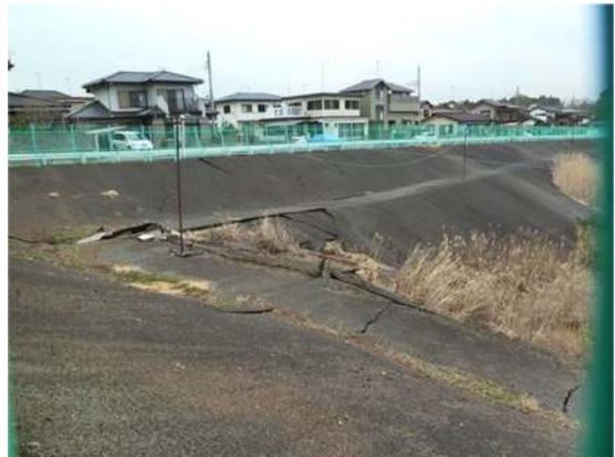
写真 3.2 液状化による噴砂跡と集水池の法面変状
