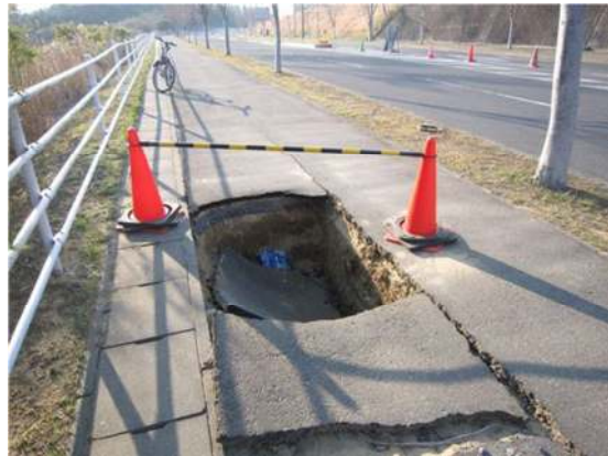
写真 2 東海村道路盛土陥没の状況
