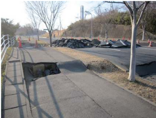
写真 2 東海村道路盛土陥没の状況
