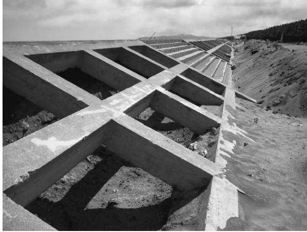
写真二 百石海岸の被害状況（桟工の中が大きく浸食）
