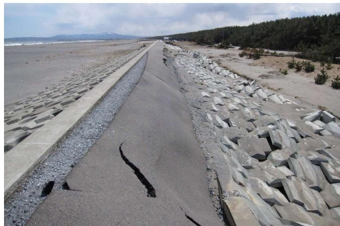
口絵写真一3 百石海岸の被害(写真左が海側であり、防波堤前面は、比較的健全であるが、背面は土砂の浸食が顕著である。)
