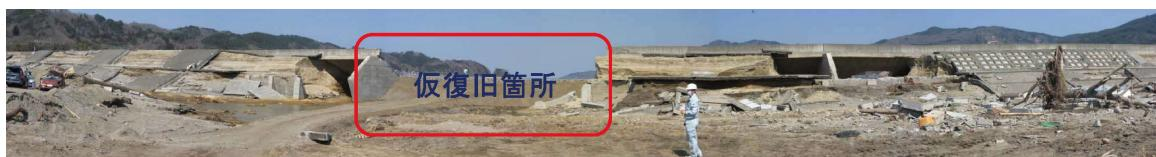
口絵写真一4 宮古市での防波堤背面からの被害状況(写真中央の仮復旧箇所は、津波により破壊されたと考えられ、その周辺の防波堤背面コンクリートの剥離と土砂の浸食・洗掘が顕著である。)
