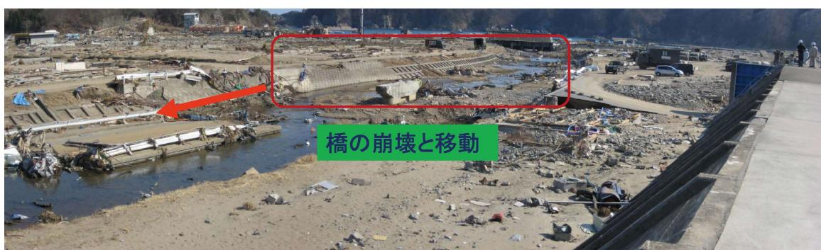
口絵写真一6 道路橋の被害状況(道路橋が津波により破壊され、陸側に約15m移動している。)
