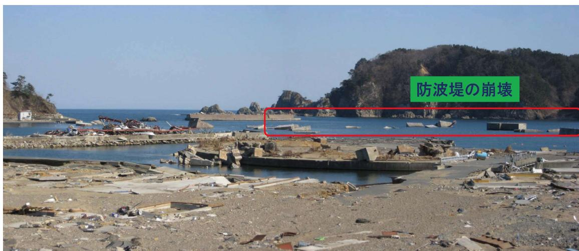
口絵写真一5 田老町の防波堤の状況(津波津波により移動、沈下が生じている。)
