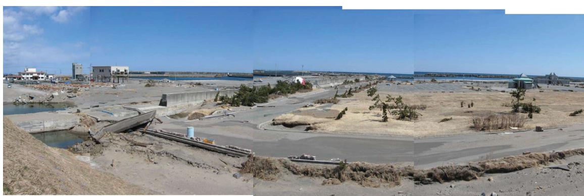
口絵写真—2 三沢漁港と海水浴場の被害全景(全域において、土砂の侵食、アスファルトの剥離が生じている。写真左は時には、大きな侵食箇所がある。)
