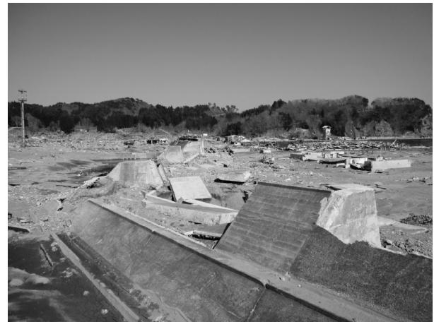
写真一8 田老町の防波堤の被害状況
