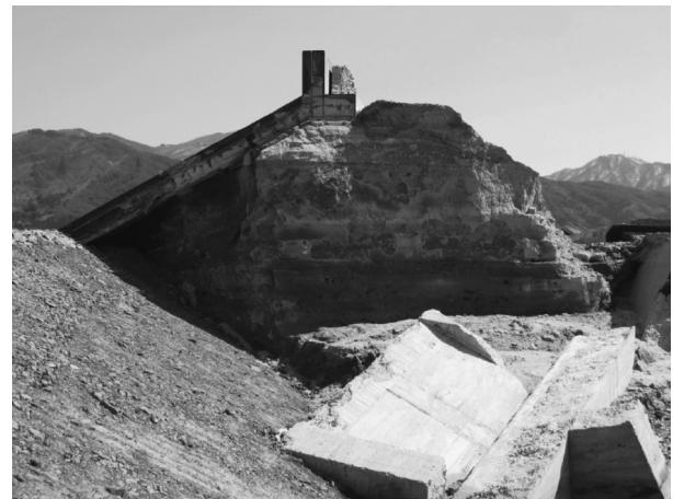
写真一7 宮古市での防波堤の損壊箇所（写真左が海側）
