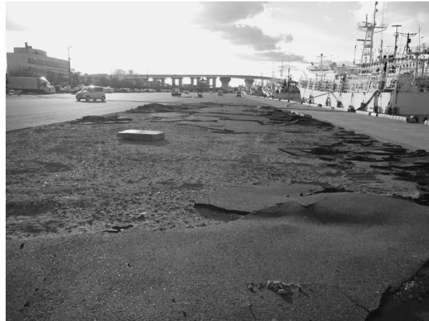
写真四 八戸港のアスファルトの剥離
