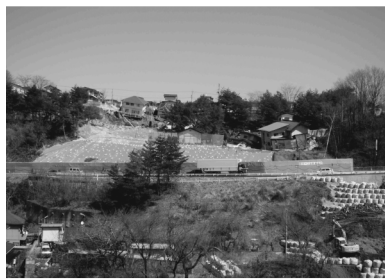
a)法面崩壊の全景
