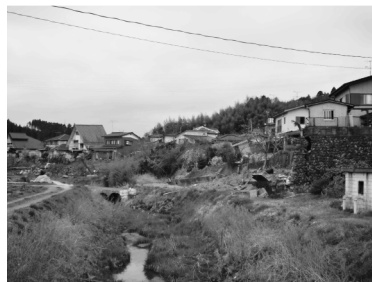
a)盛土崩壊全景
