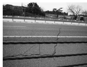
a)路面亀裂
