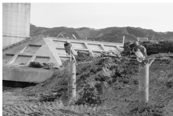
写真一12 大槌町での防潮堤水門横の基礎杭の被害
