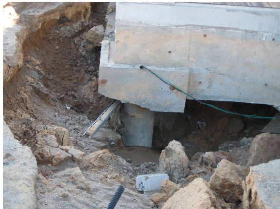
口絵写真—11 基礎形状の違いによる建築構造物の損傷程度の違い
