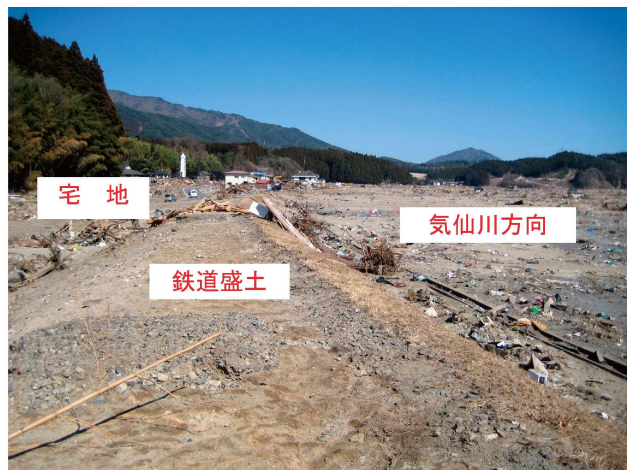
口絵写真一八 鉄道施設の被害(大船渡線 陸前矢作～竹駒間)
