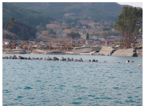
口絵写真—16 防潮堤の倒壊状況(大船渡市末崎町門之浜湾)
