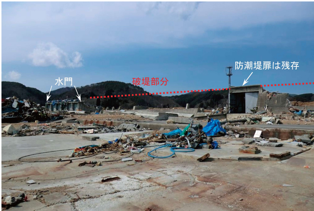
口絵写真一21 海側東方向に延びる防潮堤の破壊状況
