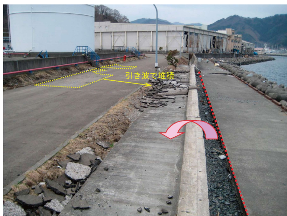
口絵写真—15 岩手県オイルターミナル内の重力式護岸の倒壊
