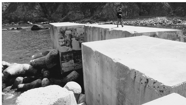
写真一11 小堀内漁港防波堤の被害
