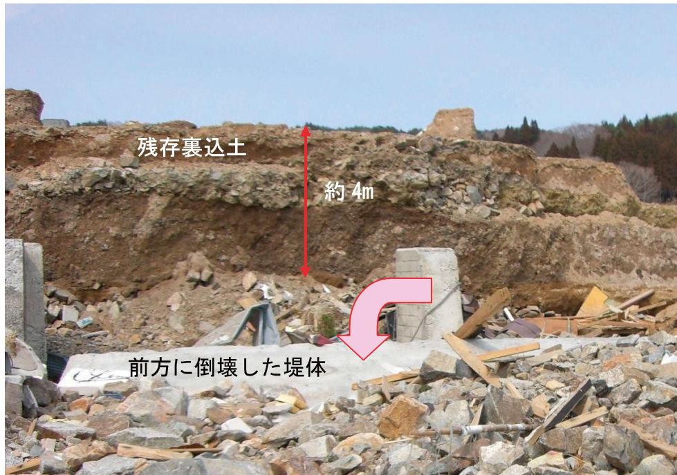
口絵写真—23 堤体の倒壊と自立裏込土
