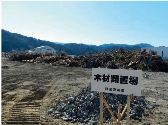
口絵写真—12 災害廃棄物の分別状況
