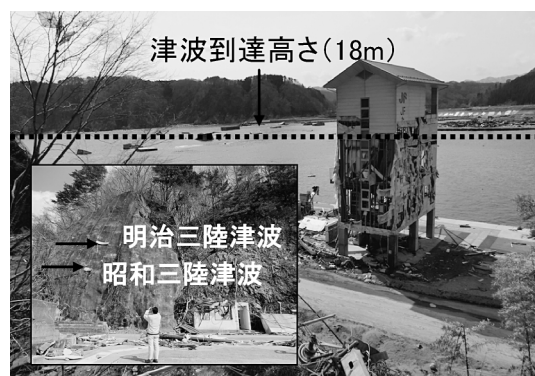
図一5 田老漁港における津波の到達高さ (左下は過去の津波到達高さ)
