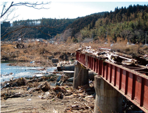
口絵写真一八 鉄道施設の被害(大船渡線 陸前矢作～竹駒間)
