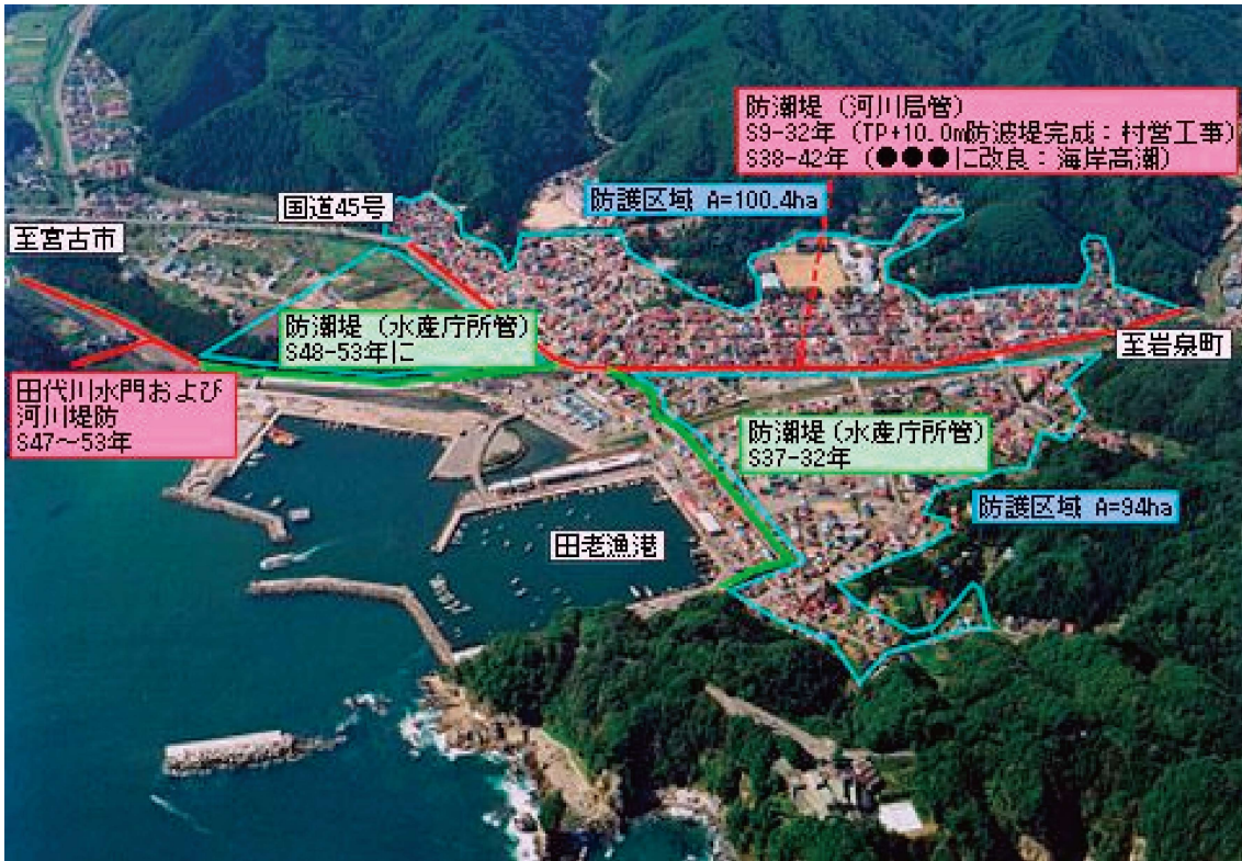
口絵写真一20 宮古市田老地区の防潮堤全景 (国土交通省東北地方整備局釜石湾港事務所ホームページより)
