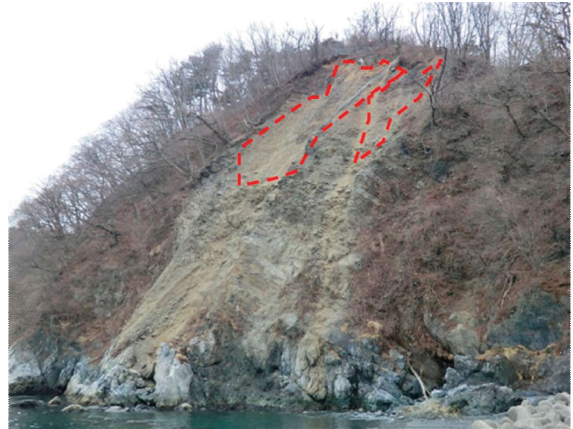
口絵写真—13 旧崩壊地の表層崩壊(釜石市大平町)
