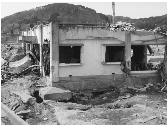
写真一7 洗掘等による基礎地盤の流出
