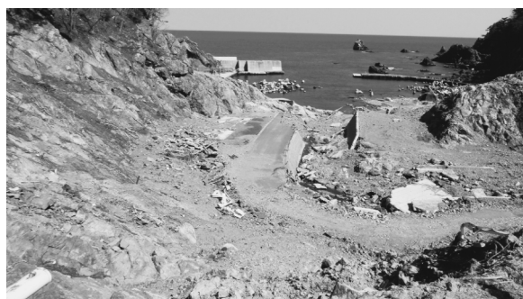
写真一10 小堀内漁港の被害（写真は高さ35 mで撮影） 写真奥の上部中央左寄りに防波堤が見える
