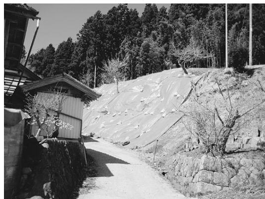
写真一1 耕作地法面の浅い崩壊事例
