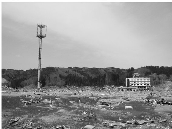
写真一6 野原地区の被害状況
