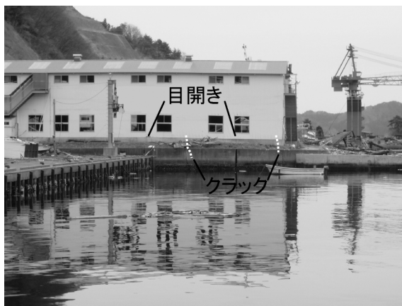
図一3 釜石港東護岸の被害状況
