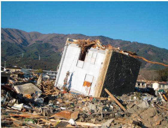
口絵写真—11 基礎形状の違いによる建築構造物の損傷程度の違い
