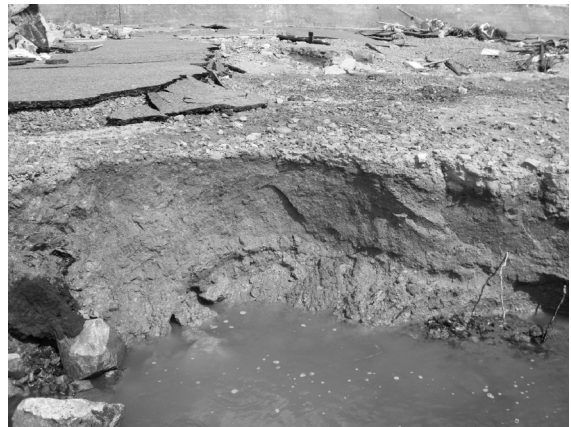
写真一9 岸壁基礎の土質材料(粘性土)
