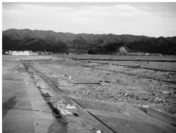
写真一5 エプロン部の不同沈下
