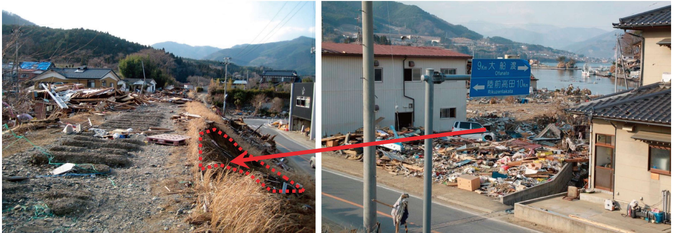
口絵写真一八 津波による鉄道盛土の洗掘
