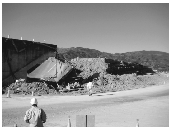
写真一3 沼田こ線橋の盛土被害
