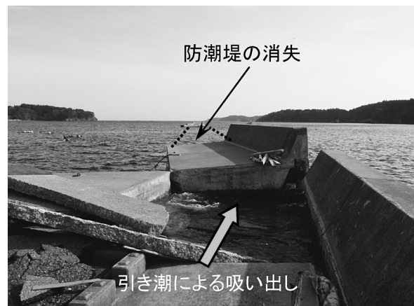
図一4 防波堤の被害（末崎町）
