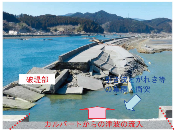
口絵写真—9 気仙大橋の落橋と河川堤防の被害(気仙川左岸)
