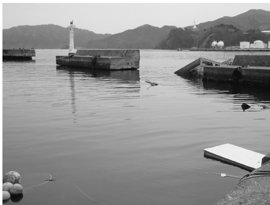
写真一4 引き波により倒壊した護岸
