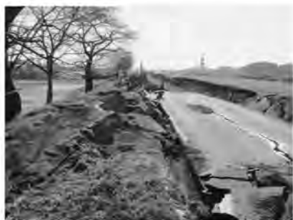
(b) 被害の様子(手前が西、奥が東方向)
