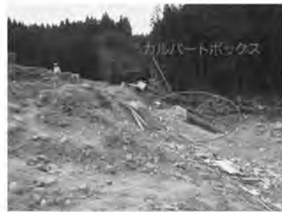
(c) プラットホーム西端からトンネル坑口までの盛土背面の様子(赤囲みはカルバートボックス)
