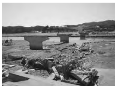
図一9 小泉大橋の桁流出、橋脚周辺洗掘、橋台上流側堤防決壊
