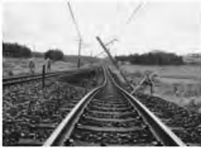
(b) 被害の様子(手前が北東, 奥が南西方向, 右手側が旧線) 7)
