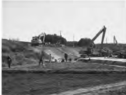
(c) 復旧工事中的の様子
