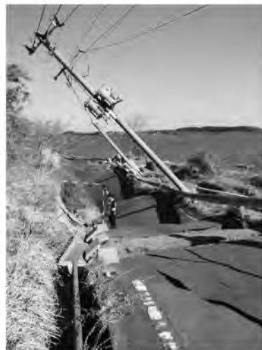
(b) 被害の様子(右側が長沼、奥が東方向)
