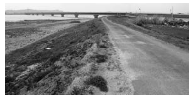
写真-27 阿武隈川左岸の河川堤防：亘理大橋下流
