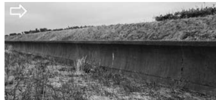
写真八 直立堤の防潮堤：三川 E
