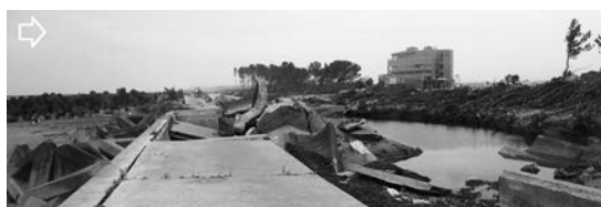
写真一10(a) 波返しと前面天端の組構造の防潮堤被害：荒浜⑤
