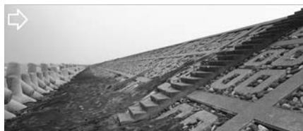
写真四 ブロック張り防潮堤の表法：二の倉⑦
