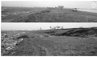
写真一30 天端幅のある裏法3段の河川堤防：阿武隈川右岸⑩
