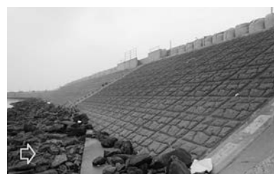
写真-29 損傷が無いブロック張りの河川護岸の表法面：阿武隈川右岸⑭
