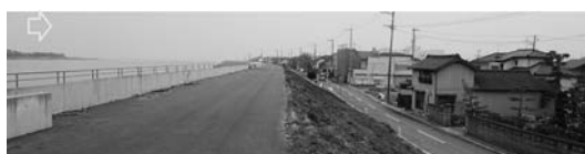
写真-25 越流が見られない河川堤防：阿武隈川右岸⑬
