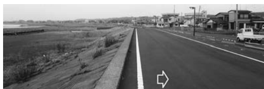
写真一11 被害のない防潮堤天端の舗装：下永井G
