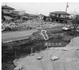
写真-24 津波が堤内地を抜けた状況：阿武隈川右岸⑫
