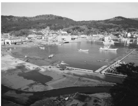
写真四 鮎川港周辺の地盤沈下 (石巻市鮎川浜, 県道2号から望む)
