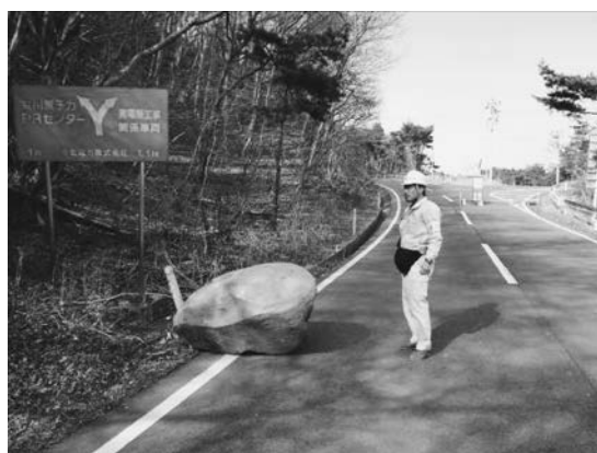
写真一15 背後斜面からの落石 (石巻市鮫浦, 県道41号)
