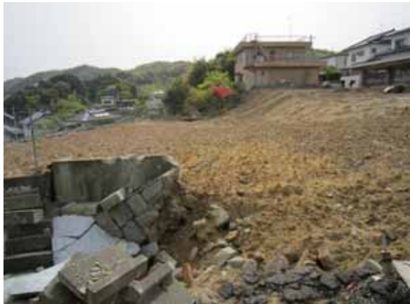
写真 2 平下荒川の斜面崩壊
