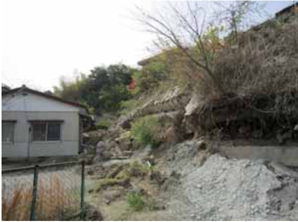
写真 3 平南白土ハツ坂団地内の斜面崩壊
