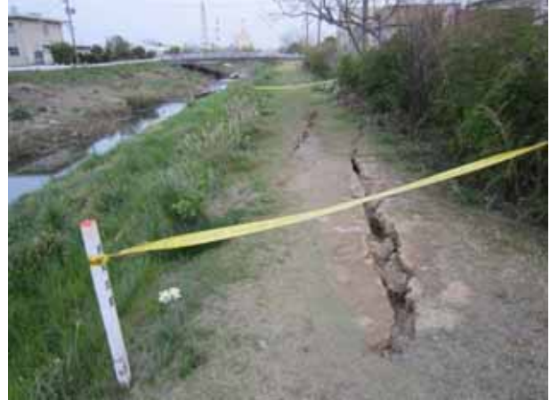
写真 9 植田町液状化および河川堤防斜面崩壊被害
