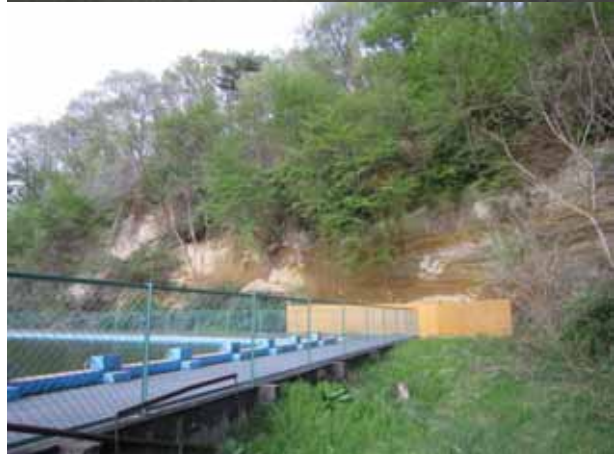
写真 8 植田小学校斜面崩壊
