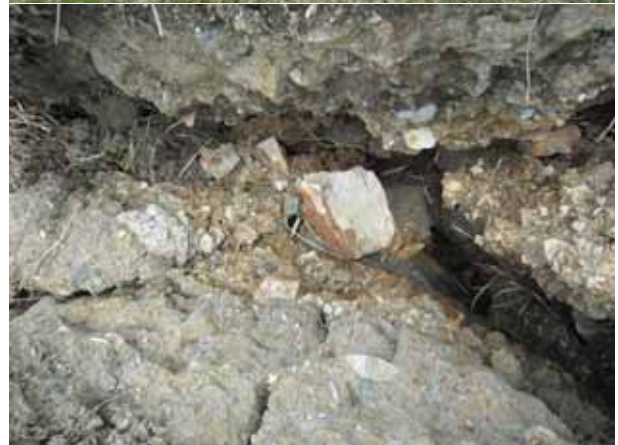
写真 5 常磐西郷町忠多地区西郷団地内の地滑り被害 小名浜上神白地区
