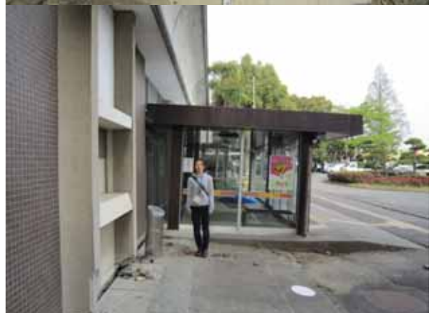
写真 7 錦町液状化被害
