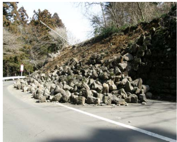
写真-3 C面石垣崩壊箇所（撮影：大沢氏）
