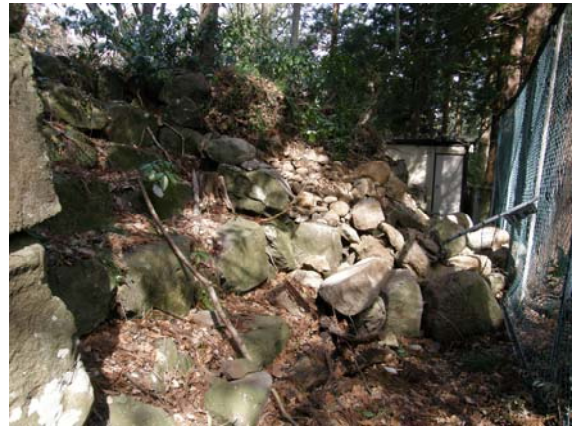
写真-1 A面崩壊箇所（撮影：大沢氏）
