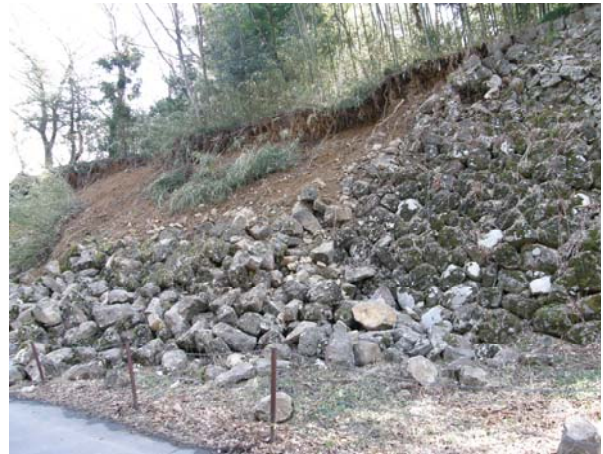
写真-5 E面の石垣の崩壊状況（撮影：大沢氏）
