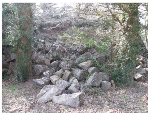
写真-7 H面の崩壊状況
