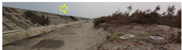
写真-17 ブロックが飛ばされた裏のり：二の倉⑦
