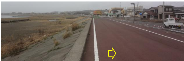
写真-11 被害のない防潮堤天端の舗装：下永井 G
