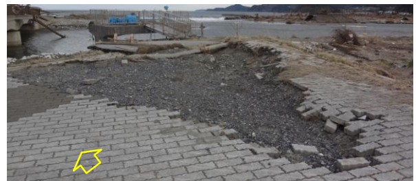
写真-106 ブロック舗装：陸前高田市
