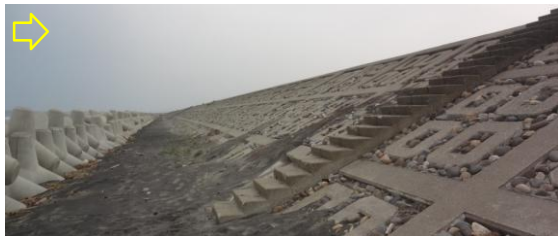
写真-4 ブロック張り防潮堤の表のり：二の倉⑦
