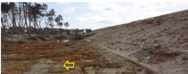
写真-78 裏のり侵食と侵食していない裏のり先：井土浦⑤
