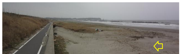
写真-3 防潮堤の前浜で発達した地形：三川E
