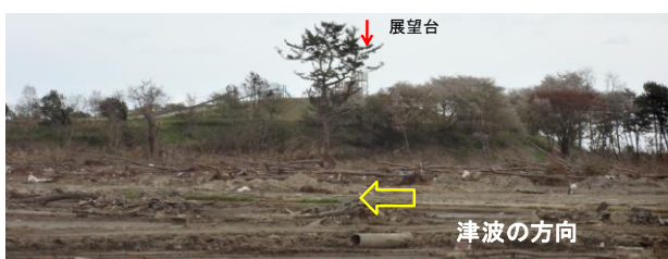
写真-54 津波を避けた高盛土：海浜公園冒険広場②
