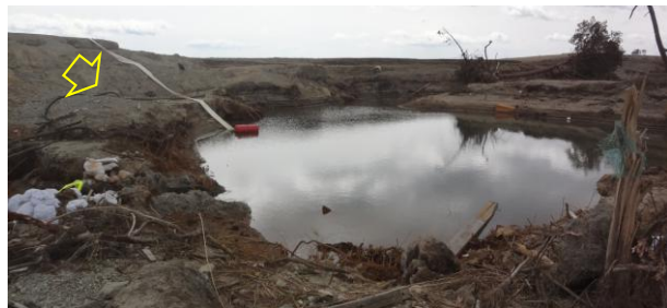
写真-76 越流箇所の堤防天端の侵食：井土浦⑤
