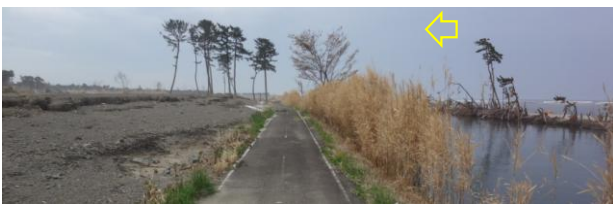
写真-83 貞山堀と新設堤防の併設部：井土浦⑤
