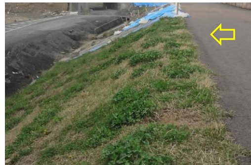
写真-99 堤防の裏のりの芝など：阿武隈川右岸⑪
