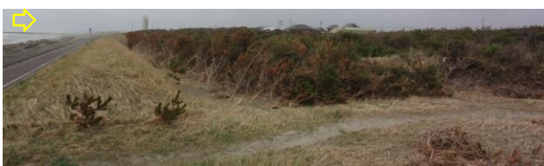
写真-50 津波（小規模）後の保安林：足川浜 B
