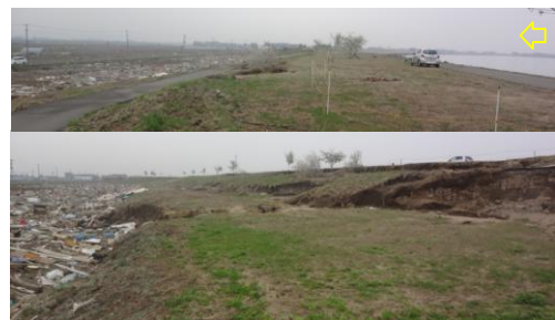
写真-30 天端幅のある裏のり 3 段の河川堤防：阿武隈川右岸⑮
