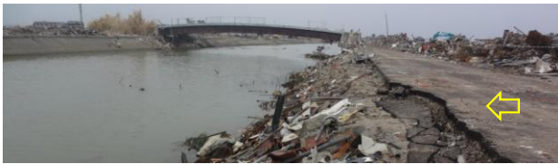
写真-66 貞山堀の津波が下る側のり面：荒浜①
