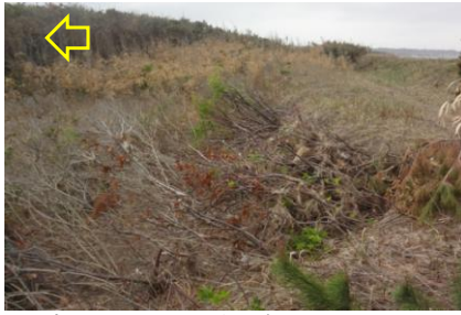
写真-81 小段構造の裏のり：三川 E
