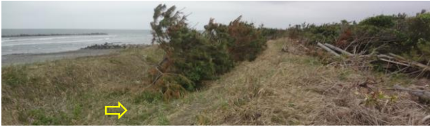
写真-82 二重構造の裏のり：三川 E
