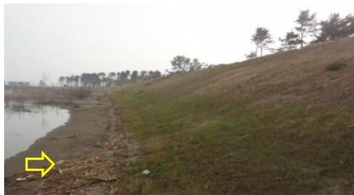
写真-72 堤防の海側の表のり：井土浦⑤
