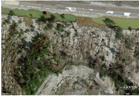
写真-48 写真-47の上空からの状況：井土浦⑤ ：上方が新設堤防と落堀
