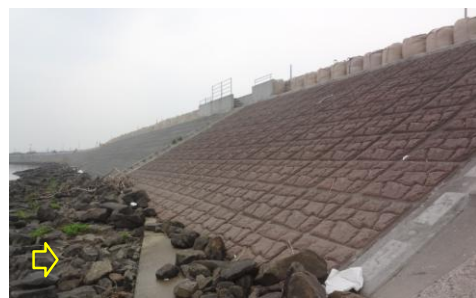
写真-29 損傷が無いブロック張りの河川護岸の表のり面：阿武隈川右岸⑭
