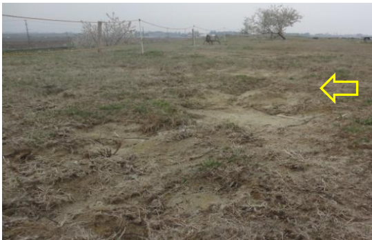
写真-97 堤防の天端の芝：阿武隈川右岸⑩
