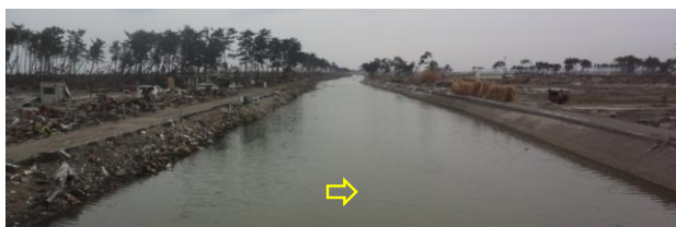
写真-63 津波が通過した貞山堀：荒浜①
