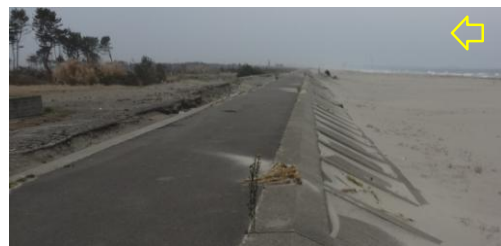
写真-2 緩傾斜堤（低い）：荒浜①
