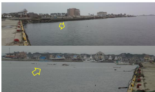
写真-64 (a) 荒浜港の沿岸：写真上は背後の海側から流入・写真下は港の北側の様子：荒浜港⑩
