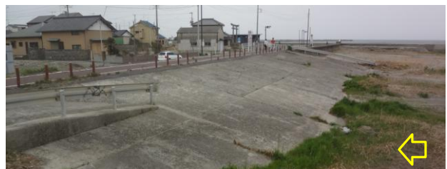
写真-1 緩傾斜堤（高い）：下永井G
