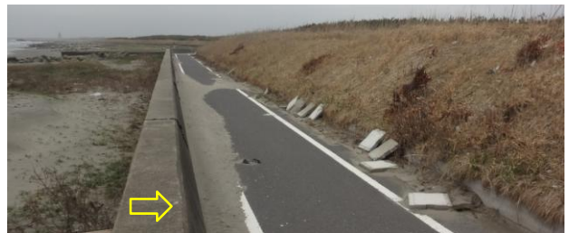
写真-87 勾配のある盛土：三川 E
