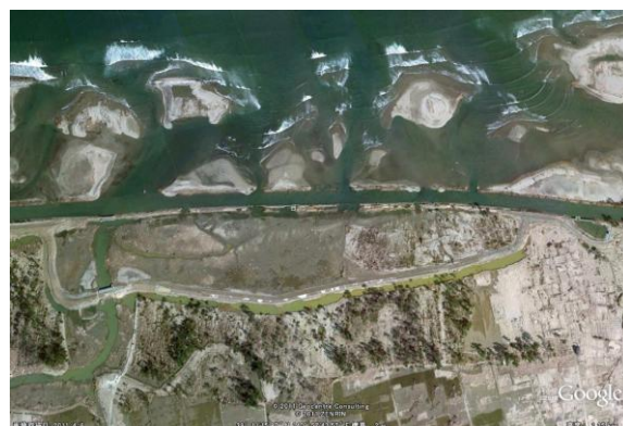
写真-71 津波後の貞山堀と新設堤防：井土浦⑤
