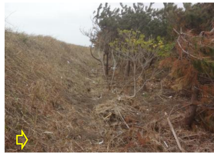
写真-80 津波（低越流）による軽微な裏のり尻侵食：三川 E
