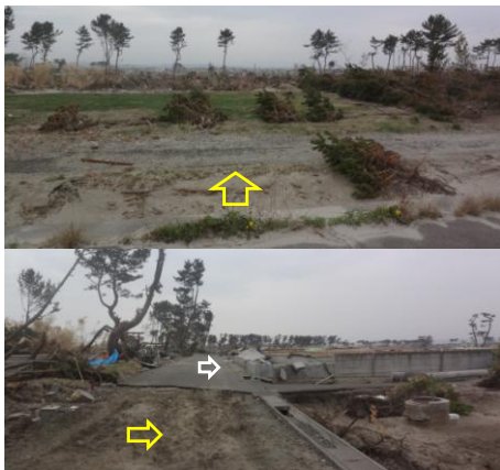
写真-49 津波の通り易さと被害の差異：写真上は防潮堤から遠望・写真下は背後の住宅地：荒浜①
