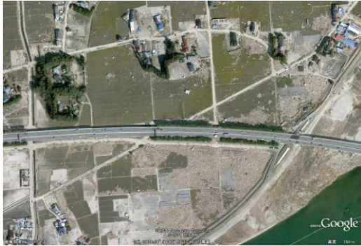
写真-93 仙台東部道路の海側（上）と山側（下）：竹野花⑥ ：盛土の左半分は高架橋、右側は名取川
