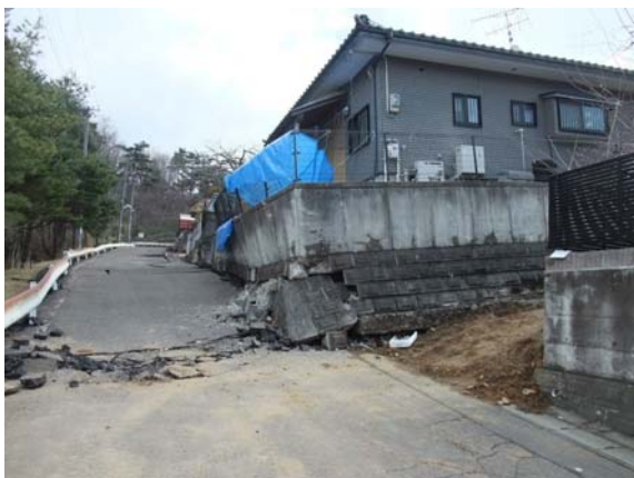
写真 5-5 仙台市青葉区折立 5 丁目
