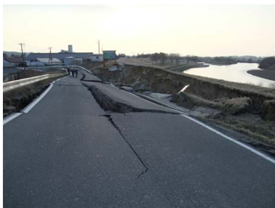
写真 3-4 志田橋右岸取付け盛土
