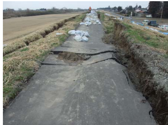
写真 4-2 江合川左岸 21km~21.2km
