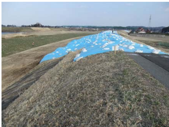
写真 3-3 鳴瀬川左岸 40.06km
