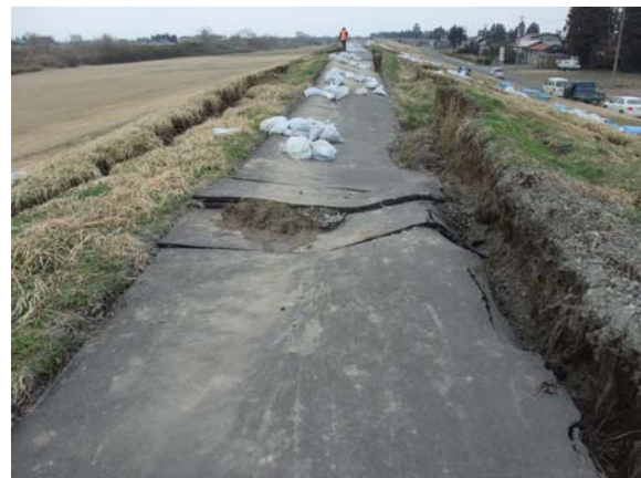
写真 4-2 江合川左岸 21km~21.2km
