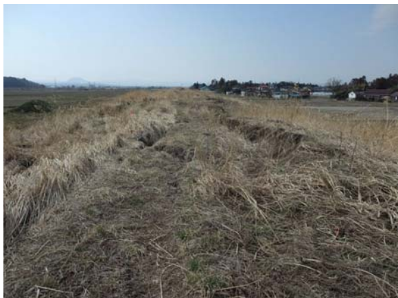
写真 3-2 鳴瀬川左岸県管理 0.6km
