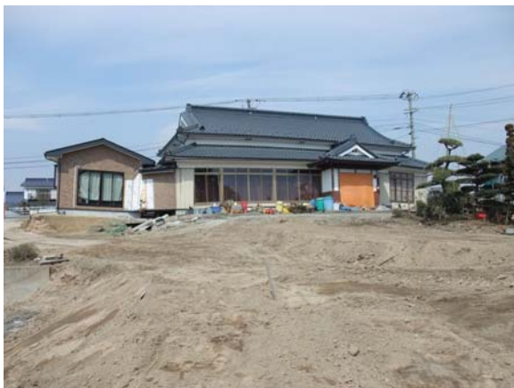
写真 3-1 347 号線多田川西の被災家屋
