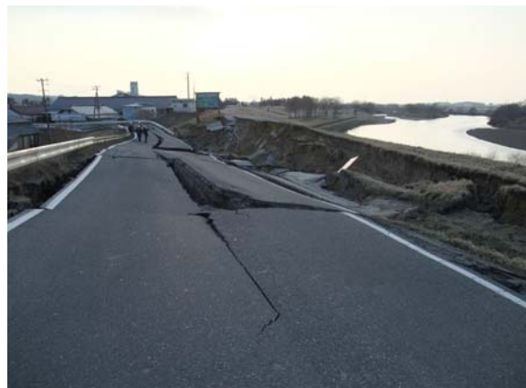
写真 3-4 志田橋右岸取付け盛土
