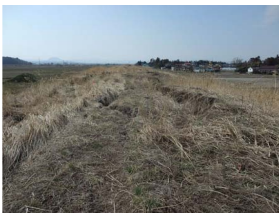
写真 3-2 鳴瀬川左岸県管理 0.6km
