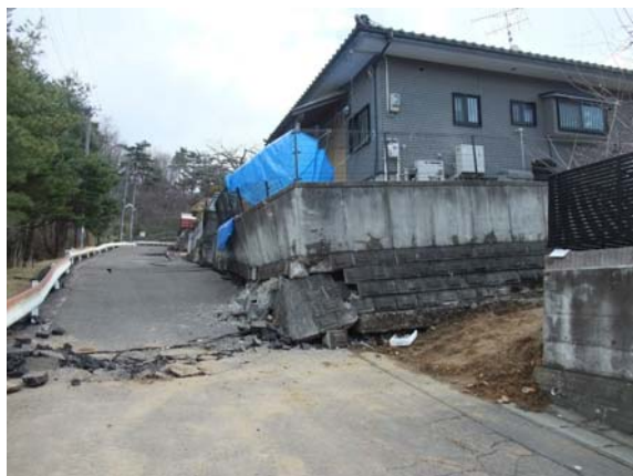
写真 5-5 仙台市青葉区折立 5 丁目
