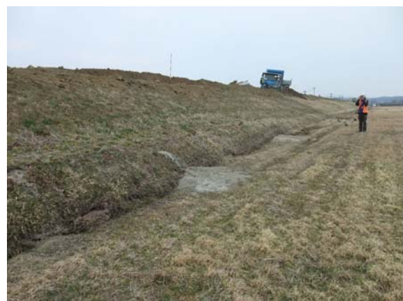
写真 4-4 江合川左岸 14.4km 堤外地
