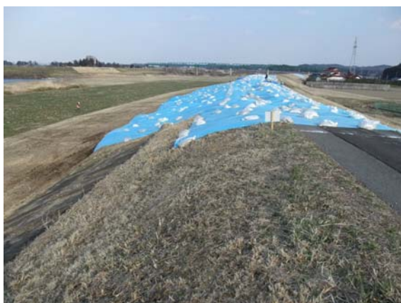
写真 3-3 鳴瀬川左岸 40.06km
