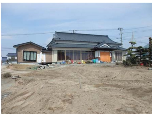
写真 3-1 347 号線多田川西の被災家屋
