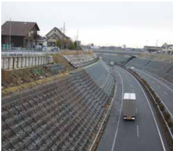
(b)修復された切り土斜面
