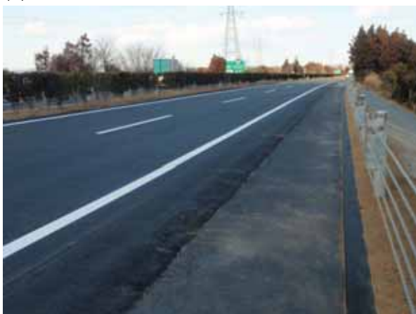
(b) 応急復旧後（3月17日17：00頃）
