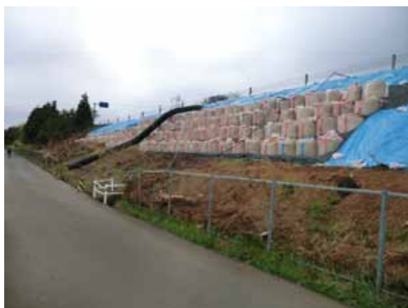
(c) 応急復旧後（土嚢による法面補強5月9日16:00頃）
