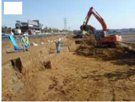
復旧状況 (段切り作業中の状況)
