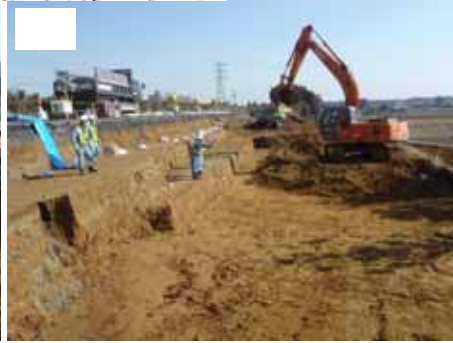
復旧状況 (段切り作業中の状況)
