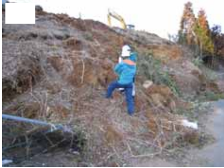
盛土のり尻部のフェンスが崩壊により変形
