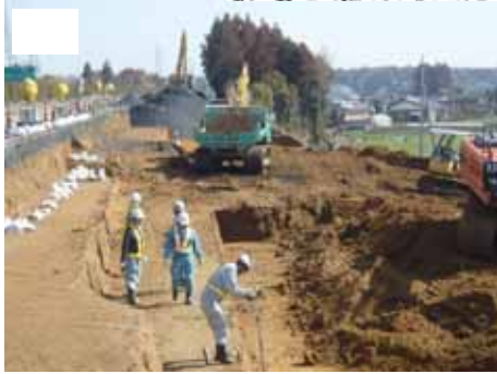
復旧状況 (段切り作業中の状況)
