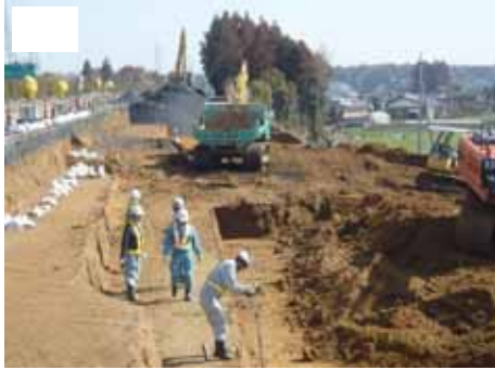
復旧状況 (段切り作業中の状況)
