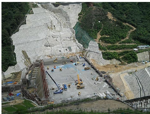
口絵写真－52 五ヶ山ダム建設現場
