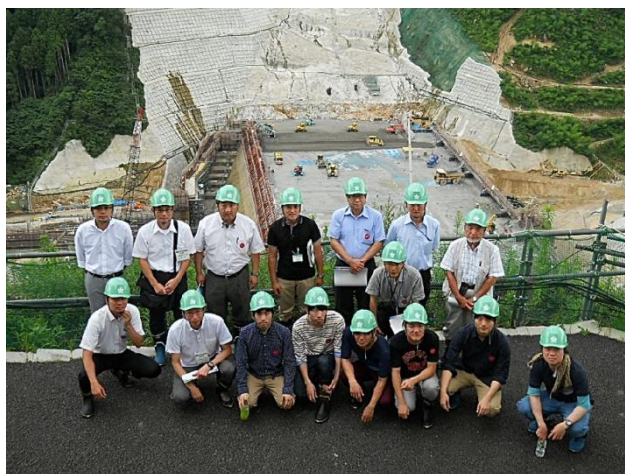
口絵写真－53 五ヶ山ダム建設現場での記念撮影
