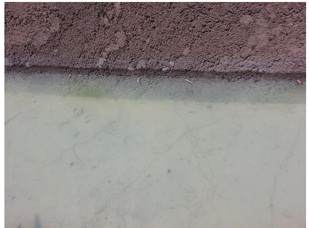
写真 スラグ材による白濁現象の事例
