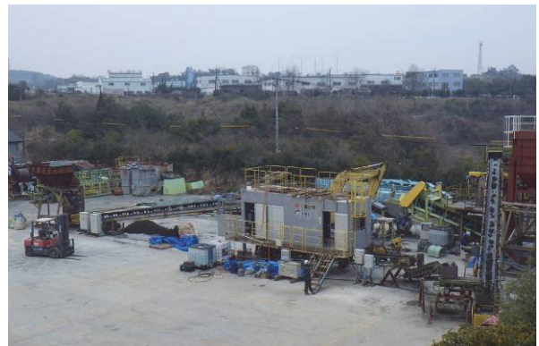
写真-1 実証実験の様子
