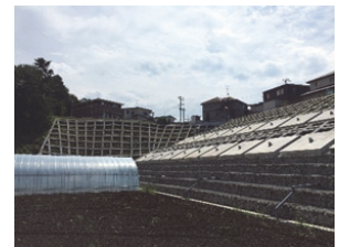
写真-2 復旧工事完了後（現場打ちのり枠工およびグラウンドアンカー工）
