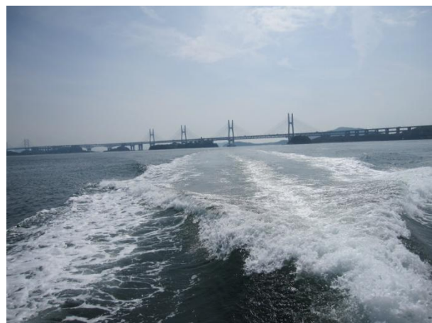
口絵写真－33 瀬戸大橋 2
