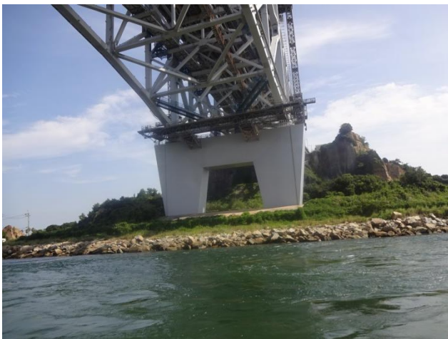
口絵写真－32 瀬戸大橋 1
