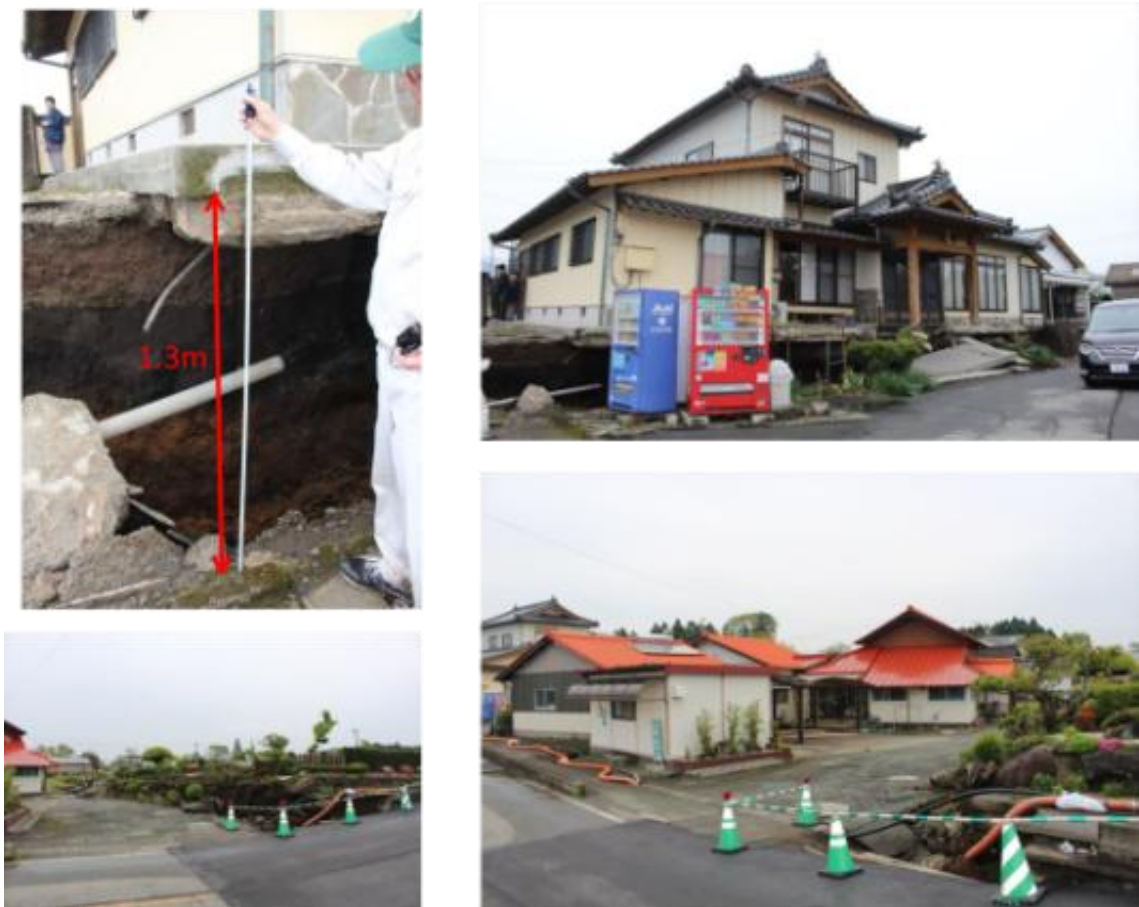
口絵写真-20 陥没による被害状況
