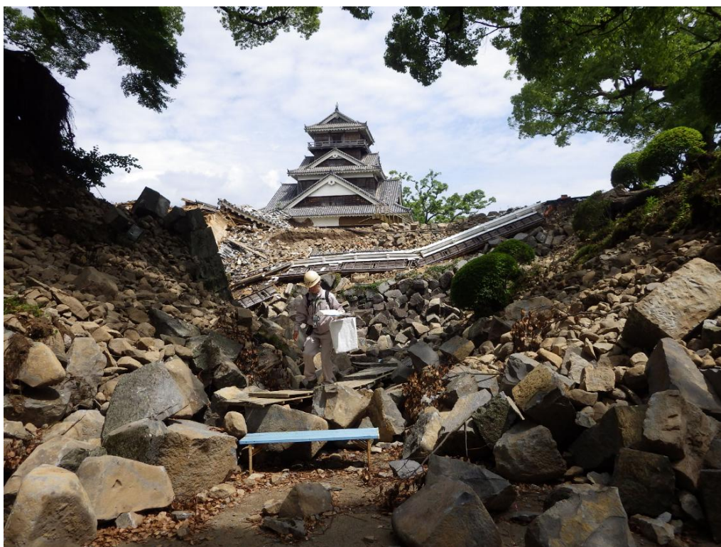
口絵写真-22 頼当御門石垣の崩壊状況(背後は宇土櫓)
