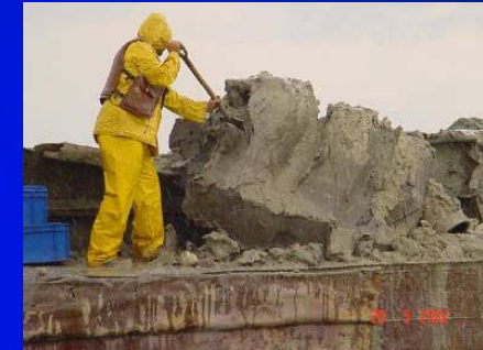
埋立材としての浚渫粘土塊 (lumpy clay)
