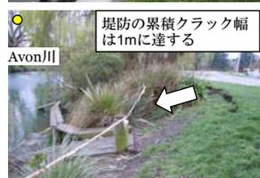
堤防道路の沈下とAvon川への変位を確認（木製栈橋の破損）
