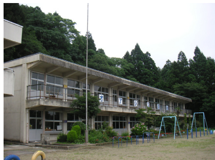
写真－3.3.2 真山小普通教室棟の全景
