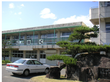
写真－3.3.1 西大崎小普通教室棟の全景
