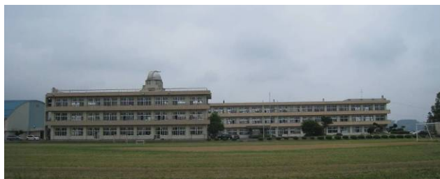
写真－3.3.8 岩ヶ崎高校校舎の全景
