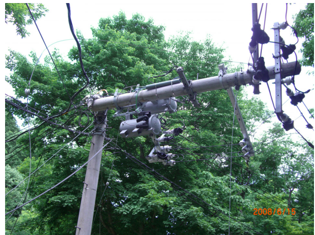
写真 - 4.4.25 土石流が電線に衝突した衝撃で折れた電柱
