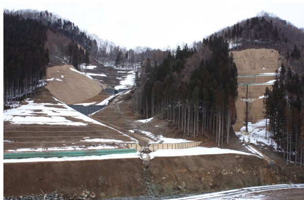
写真 - 4.4.35 山腹工と治山ダム (林野庁提供)
