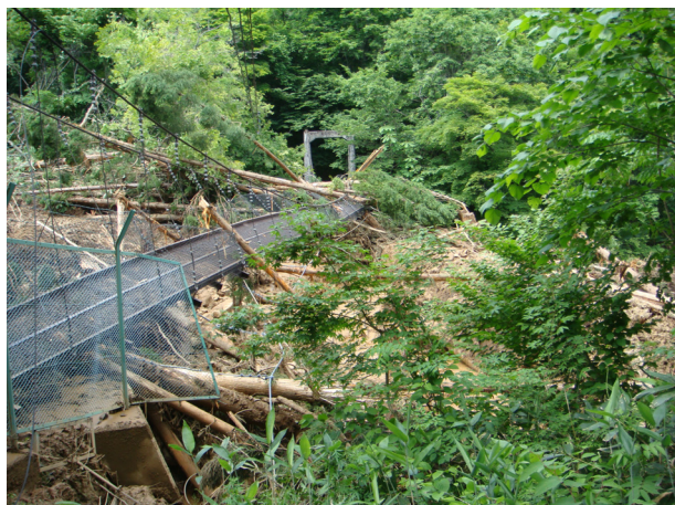
写真 - 4.4.2 行者滝上部，ドゾウ沢から流下した土石流の端部，人道橋（つり橋）に達している。：4 学会合同調査団，6/15 撮影）
