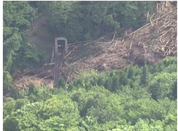
写真 - 4.4.23 吊り橋で土石流が止まった様子(行者滝)
