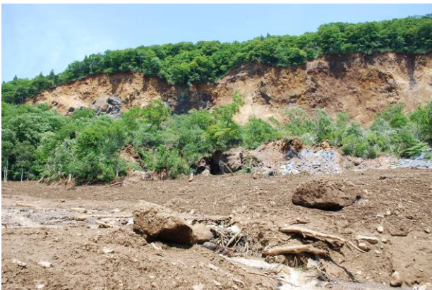
写真 - 4.4.8 地すべり発生状況
