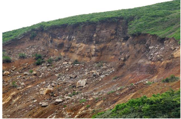
写真 - 4.4.4 源頭部の崩壊状況 (提供: 早川輝雄氏)
