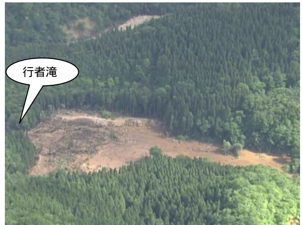
写真 - 4.4.24 行者滝で堰き止められた土石流
