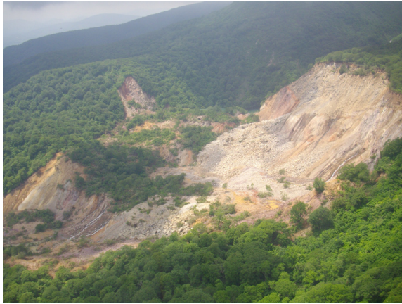
写真 - 4.4.26 産女川の大規模崩壊地。山体崩壊地及び堰き止め土体から湧出する地下水が見られる。
