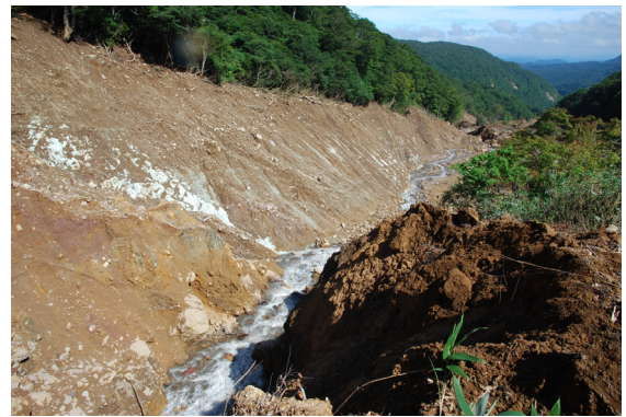
写真 - 4.4.29 源頭部直下の大規模崩壊末端から下流を望む。流下堆積痕が高い場所まで残っている。
