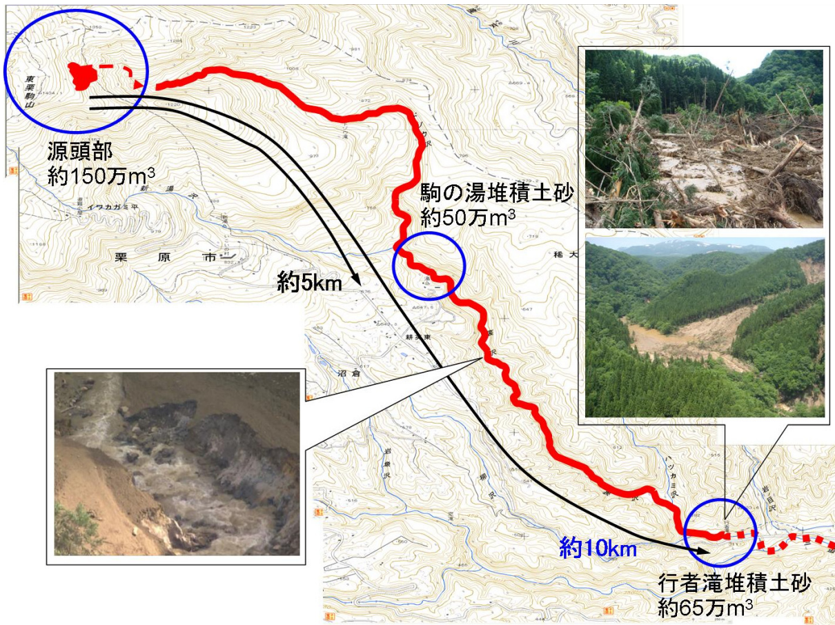
図 - 4.4.3 駒の湯を襲った土石流の流下経路と推定堆積土砂量（復建技術コンサルタントによる）
