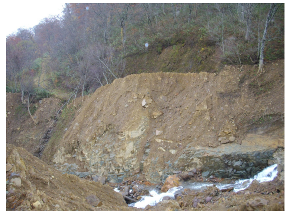
写真 - 4.4.30 旧林道橋の流出跡
