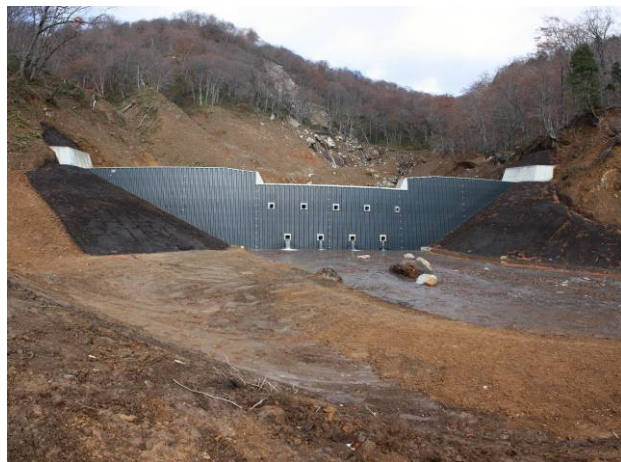
INSEM鋼製谷止工 堤長: 71.5m, 堤高: 12.0m 放水路天端幅: 4.0m, 堤体積: 4.294m 3
