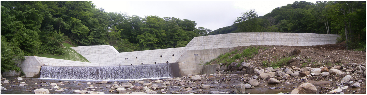
写真 - 5.4.37 セル式治山ダム直下の治山ダム (林野庁提供) (堤長:107.5m, 堤高:9.5m, 堤体積:4,283m 3 )
