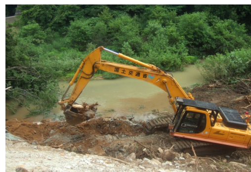
写真 - 4.4.32 二次災害の恐れが高い土砂災害の現場において、安全かつ迅速に工事を実施するため無人化施工機械にて工事を実施した（国土交通省提供）
