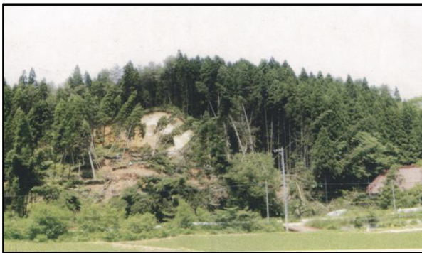
写真 - 5.2.4 楓木立地すべり
