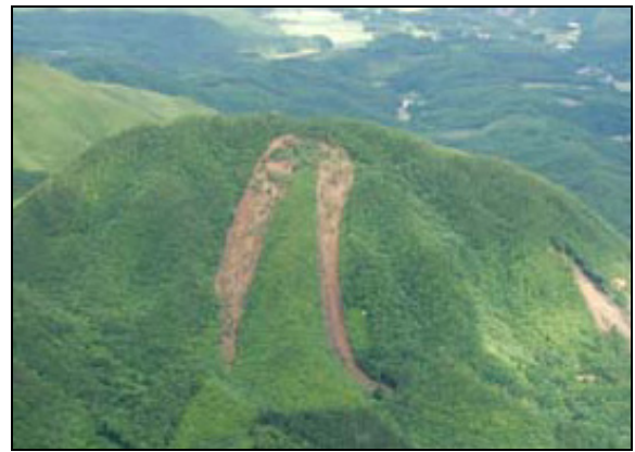
写真 - 5.2.2 山王山地すべりと沢沿いに流下した土砂
