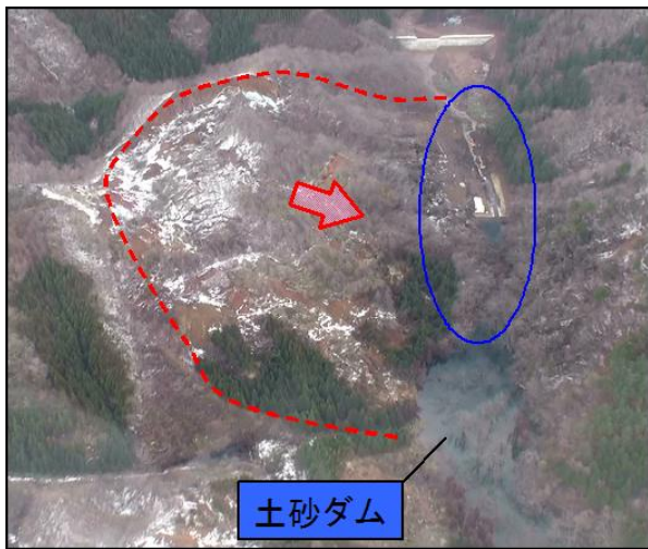
写真 - 5.2.5 増沢地すべり
