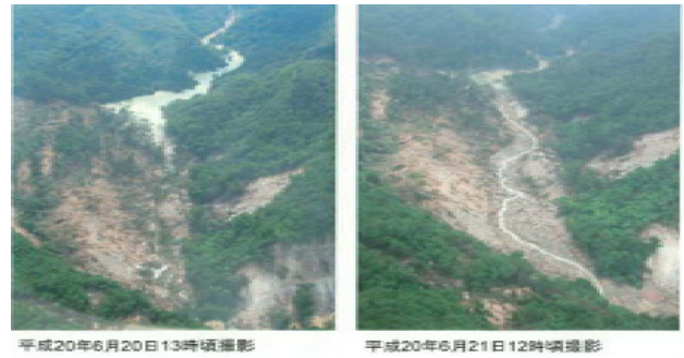
写真 - 6.4.7 沼倉裏沢地区（宮城 9）の越流状況 （撮影：国土交通省東北地方整備局，2008/6/20～21）
