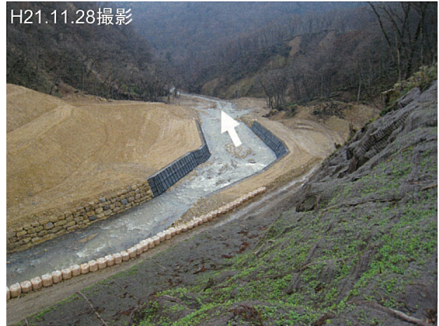
写真 - 6.4.5 湯ノ倉温泉地区（宮城 5）の本復旧後の排水路 （撮影：国土交通省東北地方整備局，2009/11/28）
