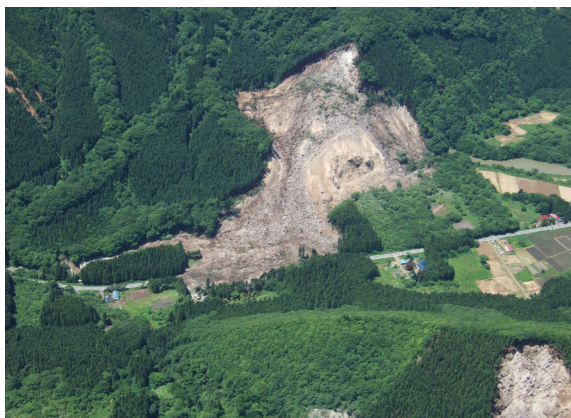
写真 - 6.1.8 宮城 3 : 小川原地区 (幅 200m, 長さ 520m, 490 千 m 3 ) 2)
