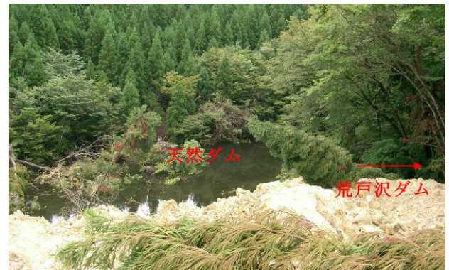
写真-6.6.2 天然ダムを西側から撮影
