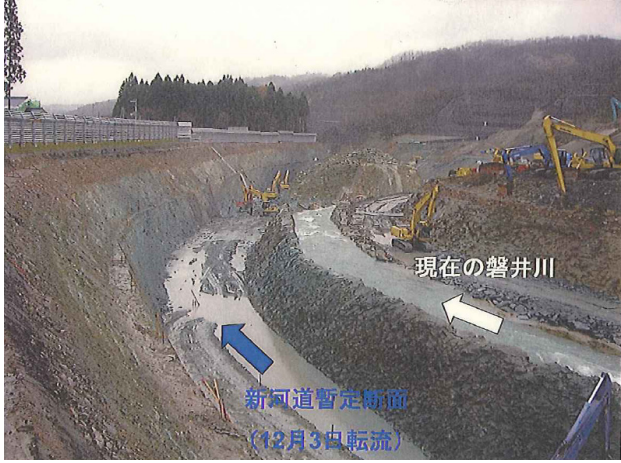
写真 - 6.4.1 市野々原地区(岩手2)の本復旧後の流路(撮影: 国土交通省東北地方整備局, 2009/11/17)
