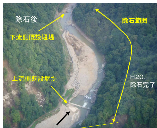
写真 - 6.4.4 温湯地区 (宮城 4) の除石工 (撮影: 国土交通省東北地方整備局)
