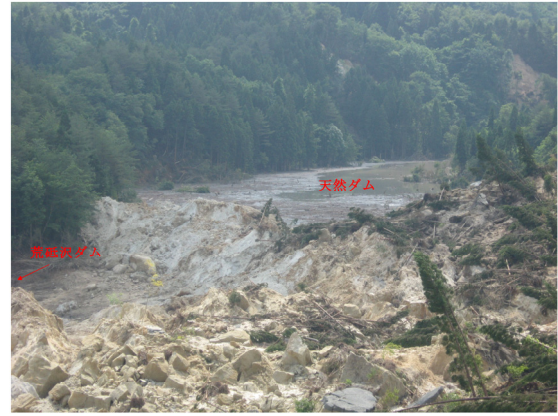
写真 - 6.6.5 天然ダム を下流側から撮影
