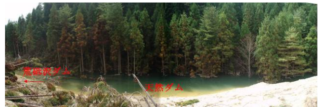
写真 - 7.6.8 天然ダム を東側から撮影
