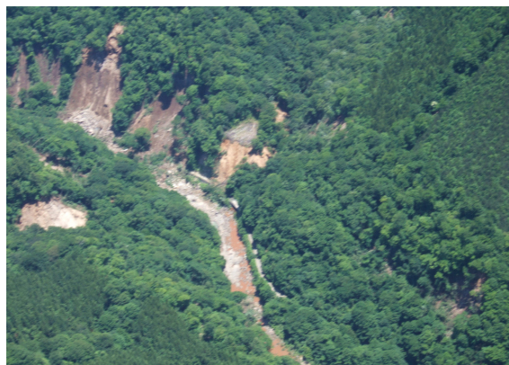
写真 - 6.1.9 宮城 4 : 温湯地区 (幅 80m, 長さ 580m, 740 千 m 3 ) 2)
