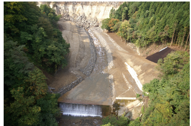
写真 - 6.4.8 沼倉裏沢地区（宮城 9）の復旧後の流路 （撮影：国土交通省東北地方整備局，2008/10/8）
