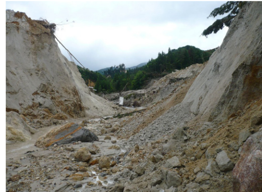
写真 - 6.6.6 天然ダム 閉塞部(決壊部は大きくえぐれている)
