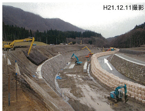
写真 - 6.4.3 小川原地区 (宮城 3) の本復旧後の排水路 (撮影: 国土交通省東北地方整備局, 2009/12/11)
