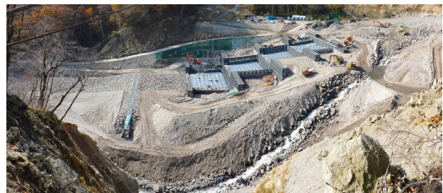
図 - 6.4.2 湯浜地区（宮城 8）の本復旧断面の模式図 （撮影：国土交通省東北地方整備局，2009/10/30）
