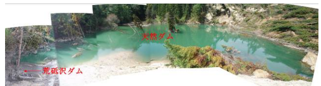
写真 - 6.6.9 天然ダム を東側から撮影
