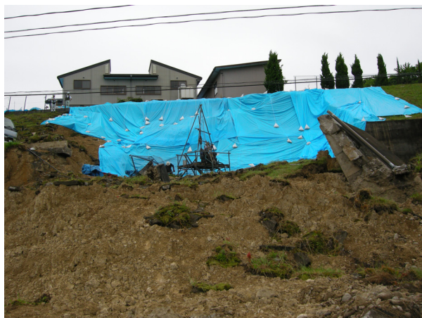
写真-7.1.1 宮城県栗原市鷺沢工業高校の盛土の崩落
