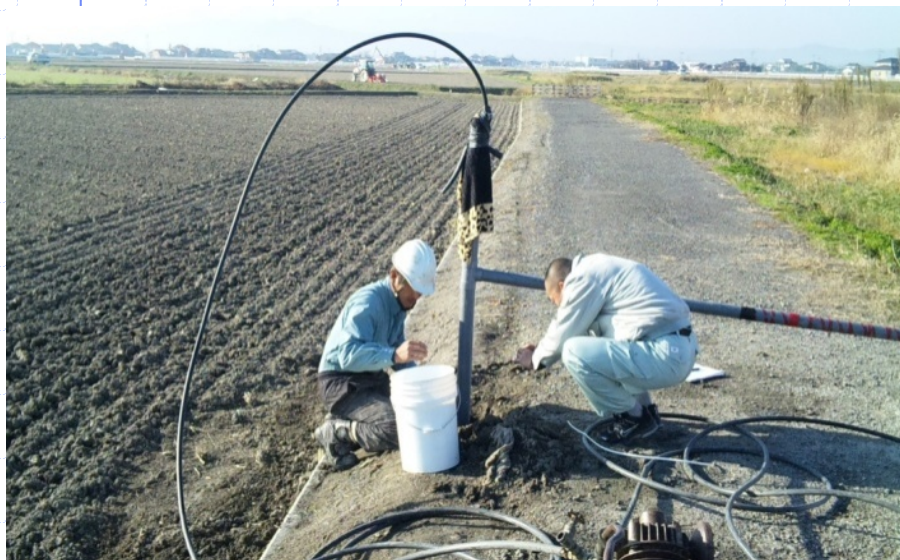
エアリフト工法による観測井の 洗浄状況
