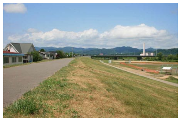
(a) 北海道石狩川上流の堤防と高水敷の利用状況
