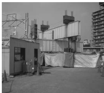
写真-2.5.1 載荷試験
