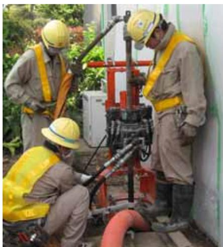
図 6.2.16 超小型の高圧噴射攪拌施工機<sup>12)</sup>
