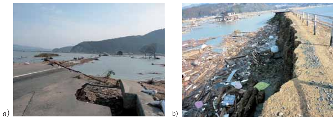
図 3-6 相馬港における矢板式岸壁の被害（港湾空港技術研究所提供）
