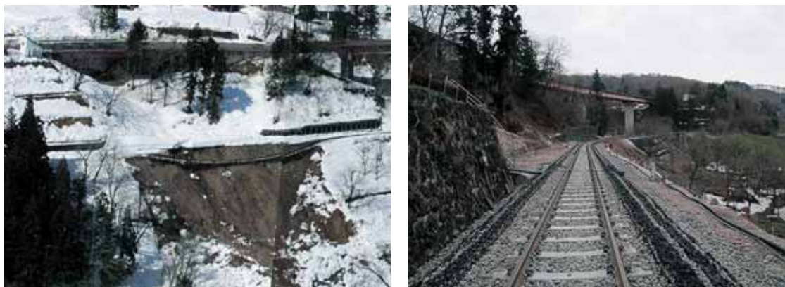
図 3-11 JR 東日本飯山線横倉～森宮野原間の盛土の崩壊と剛で一体の壁面工を持つジオテキスタイル補強土擁壁で強化復旧（JR 東日本提供）
