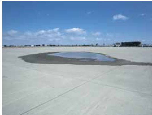
図 3-2 仙台空港での地盤液状化によるエプロン部の沈下（地盤液状化未対策部）（港湾空港技術研究所提供）
