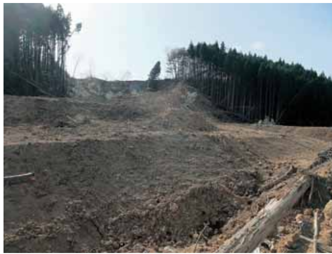
図3-31 白河市葉の木平での自然斜面の崩壊（安田進）
