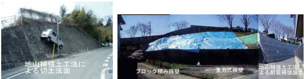
図 3.3 崩壊を免れた地山補強土工法による切土斜面（小高猛司）
