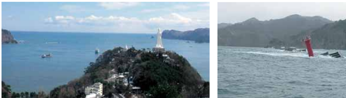
図 3-5 釜石港の津波による防波堤の被害（港湾空港技術研究所提供）
