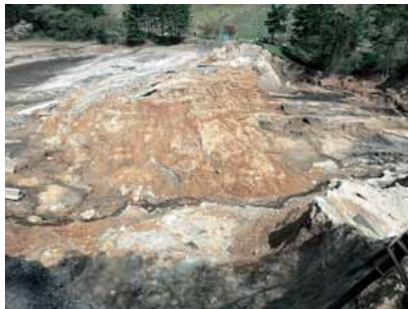
図 3-4 藤沼ダム（須賀川市）北東側の堤体決壊箇所（安田進）
