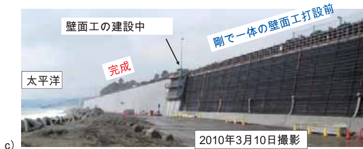
図 2-7 神奈川県西湘バイパスの台風の波浪で崩壊した重力式防波堤のジオシンセティック補強土擁壁による強化復旧
