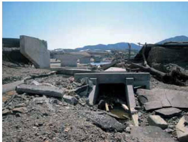
図 3-8 宮城県気仙沼市本吉町津谷川左岸： 橋台上流部での河川堤防が決壊，右岸でも同様に橋台上流部が決壊．左岸の決壊幅は約 16m であり，橋樋管などの構造物があった形跡があることから，それが弱部になり決壊した可能性もあるが，橋台上流側のみが決壊した原因は不明である．また，橋台下流側では橋台背面が浸食されていたが，それより下流側の堤防には目立った被害はみられなかった（渦岡良介）
