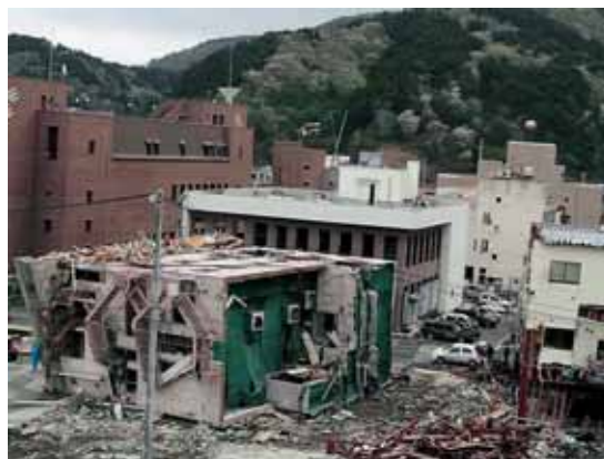
図 3-9 女川町における津波により転倒した RC 建築物（小高猛司）
