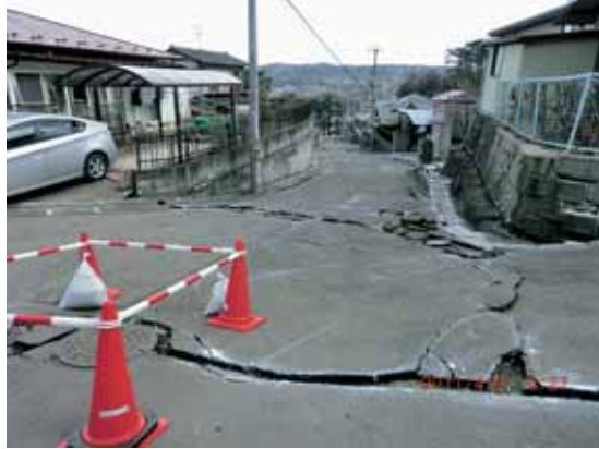
図 3-13 宅地の被災例（仙台市青葉区折立）（風間基樹）
