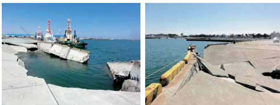
図 3-6 相馬港における矢板式岸壁の被害（港湾空港技術研究所提供）
