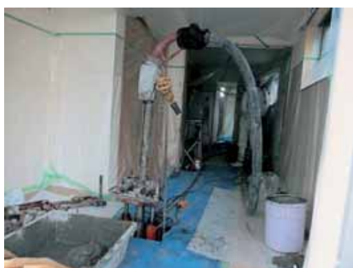
図3-19 浦安市でのCPGによる地盤の直下改良(安田進)
