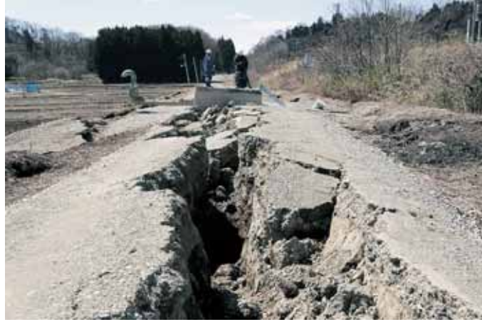
図 3-31 農業用幹線パイプラインの被災例（約 1.4km にわたり亀裂・沈下、亀裂の深さは最大で 1.6m 以上、埋戻し土の液状化によりパイプが浮上（毛利栄征）
