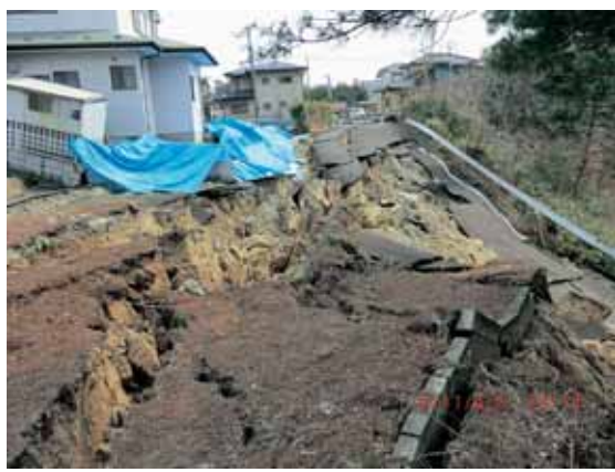
図 3-15 a) 宮城県白石市での、1978 年宮城県沖地震で被災した造成宅地が再び被害を受けた事例 (Google 画像)、b) 谷埋め盛土部の斜面開口部の変状事例 (風間基樹)、c) 事例 b) の位置 (上部の谷埋め盛土部の斜面開口部) (佐藤真吾)
