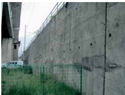
図 2-8 東北本線名取川橋梁に隣接するジオシンセティック補強土擁壁（今回の地震で無被害、岡本正広）
