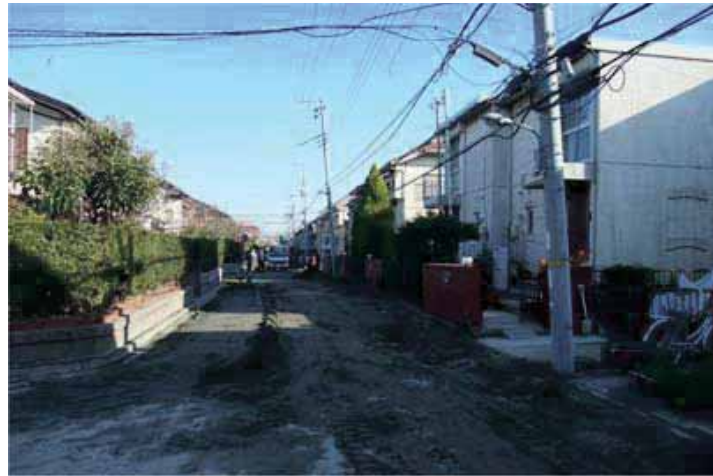
図 3-17 地盤の液状化による家屋・道路の被害 (安田進)
