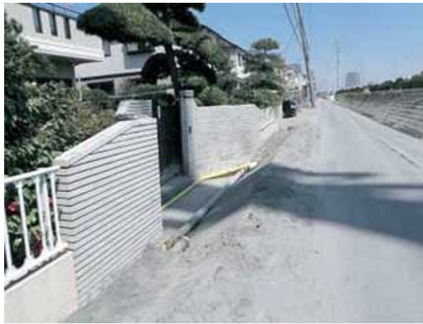
図 3-20 浦安市での宅地と道路の不同沈下（石原雅規）
