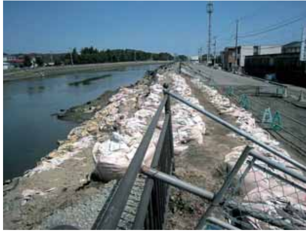
図 3-30 宮城県多賀城市砂押川右岸における地震動による河川堤防の変状、堤内地が浸水被害（渦岡良介）
