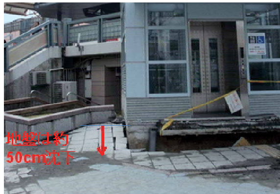
図 3-26 浦安市における地盤の液状化による地盤の沈下（安田進）
