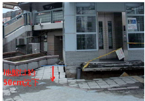
図5 浦安市、地盤の液状化による沈下(安田進)
