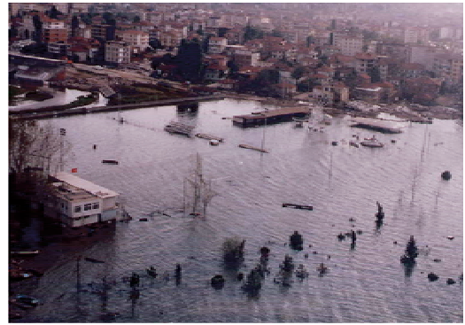
図4 トルコ・コジャエリ地震によるギョルチュックの冠水状態(安田進)
