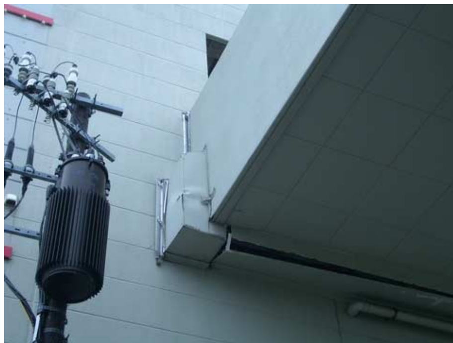
歩道橋接合部の座屈
