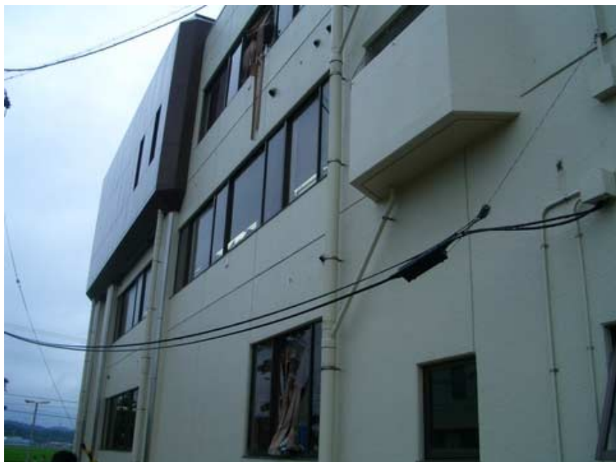
役場窓ガラスの割れ
