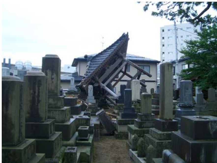
鐘楼の跳びによる転倒
