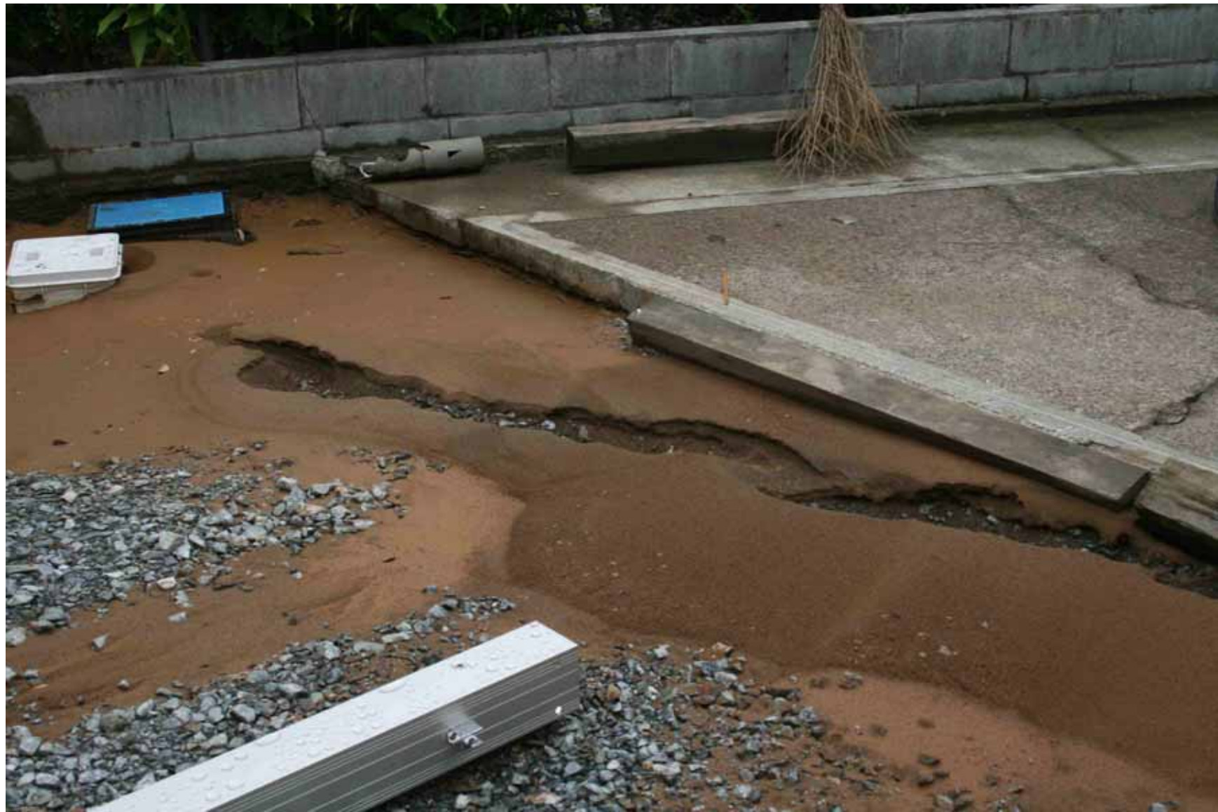
写真36 柏崎市橋場町12、開運橋上流側で鯖石川左岸堤内法先民家の地盤の噴砂
