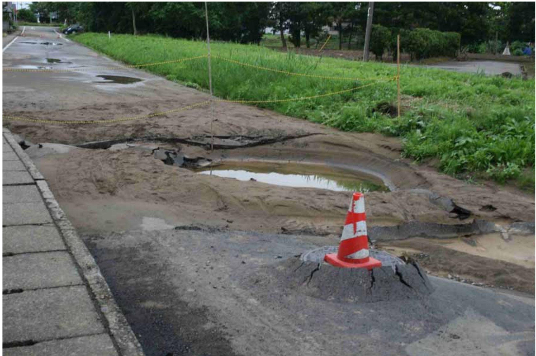
写真32 同上(柏崎市橋場町)、道路のクレーターとマンホールの浮き上がり
