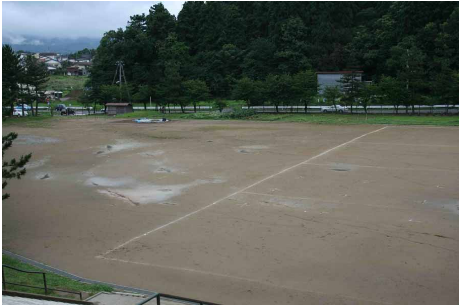
写真16 柏崎市南半田、半田小学校グラウンドの液状化に伴う亀裂
