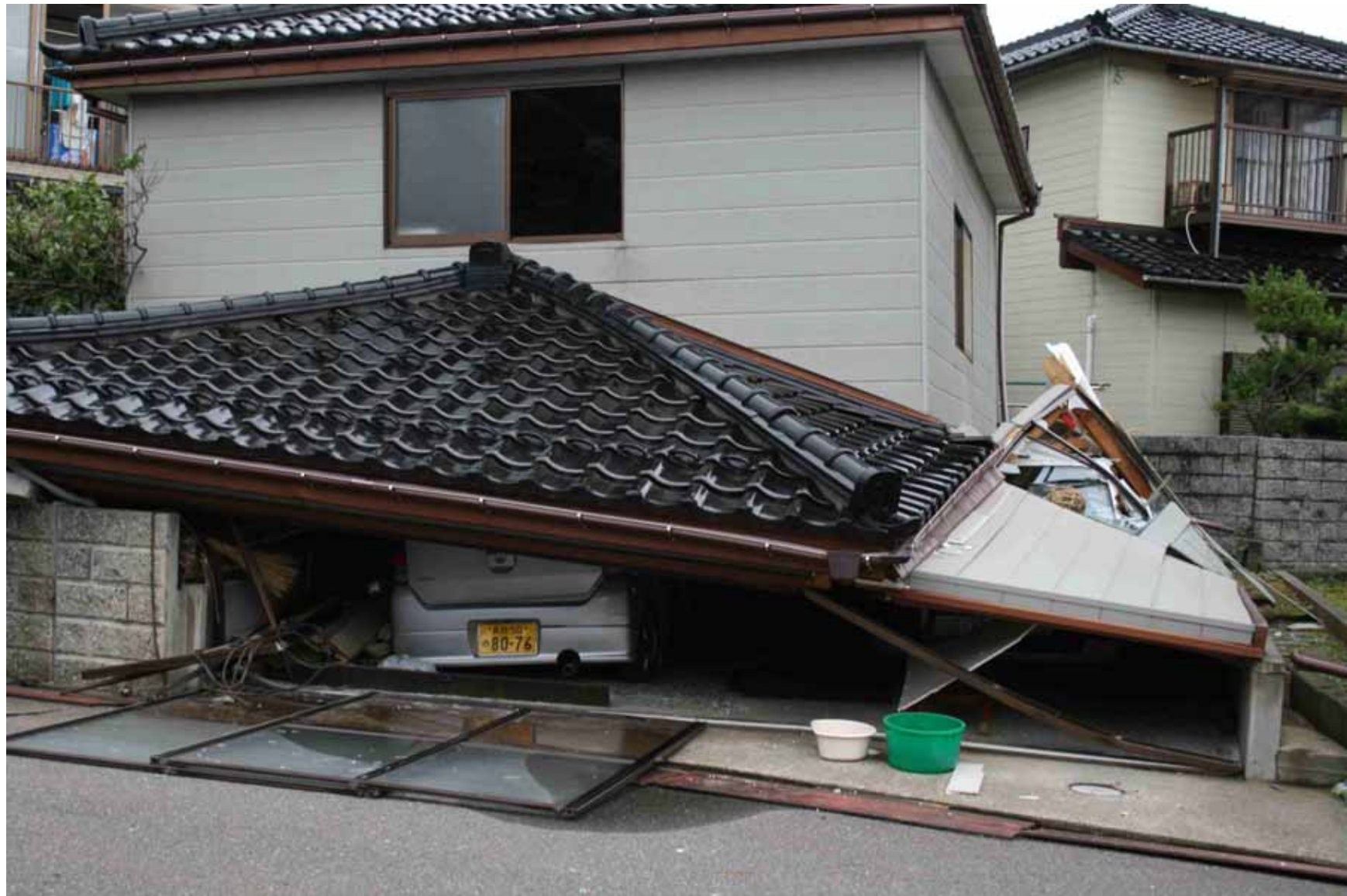
写真37 同上(柏崎市橋場町12)、1階がピロティーの民家の崩壊
