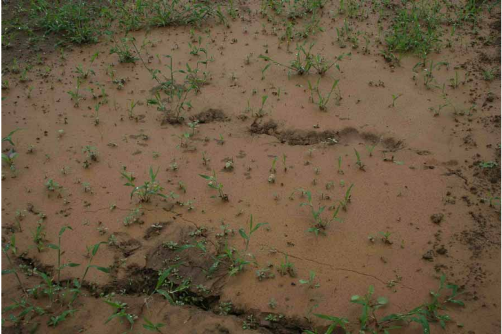
写真30 柏崎市橋場町7丁目、鯖石川旧河道上の民家の庭先、液状化痕(噴砂)・・・ 開運橋近傍の鯖石川左岸と越後線の間旧河道沿い住宅地は、液状化による被害が大
