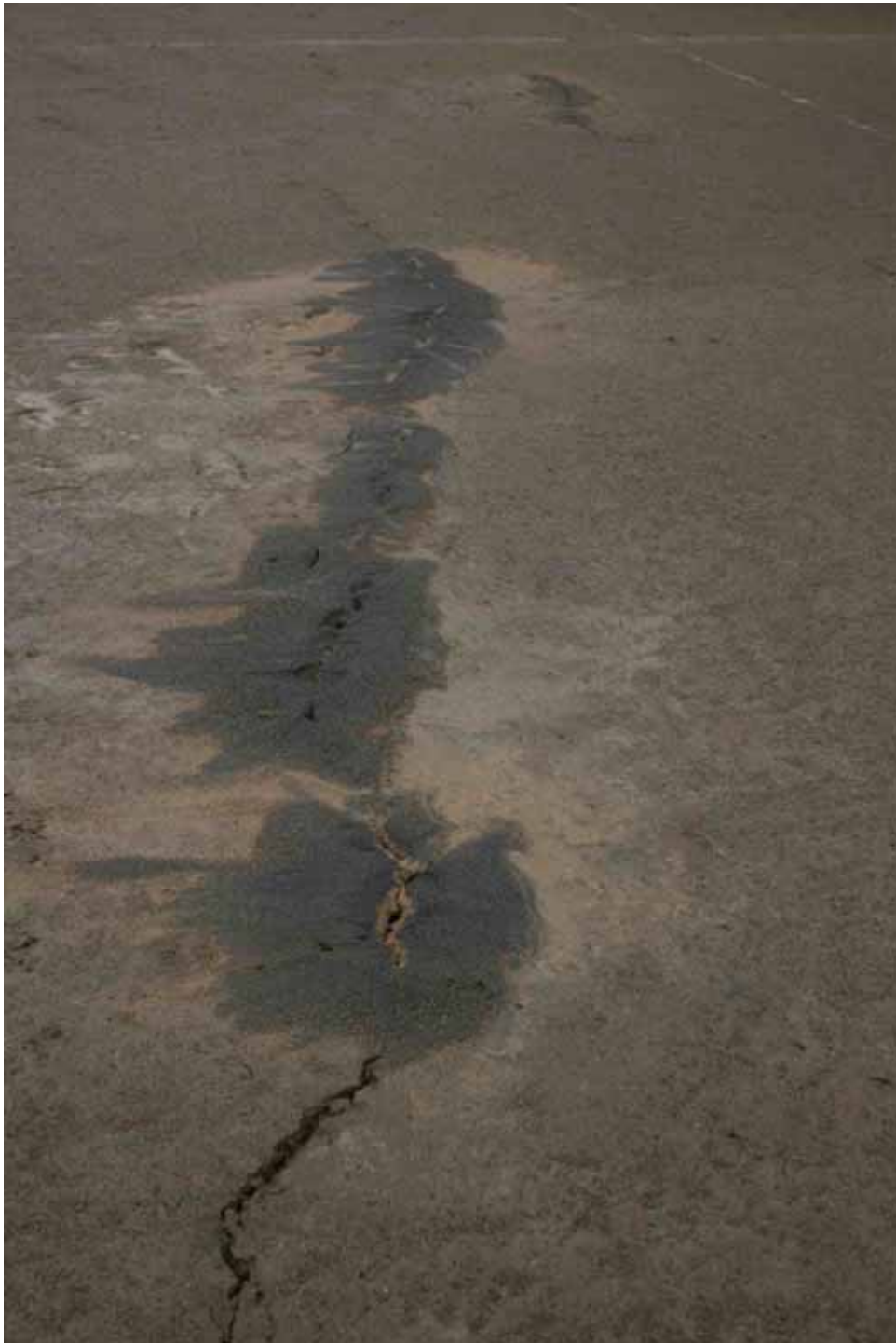
写真17 同上、半田小学校 グラウンドの噴砂
