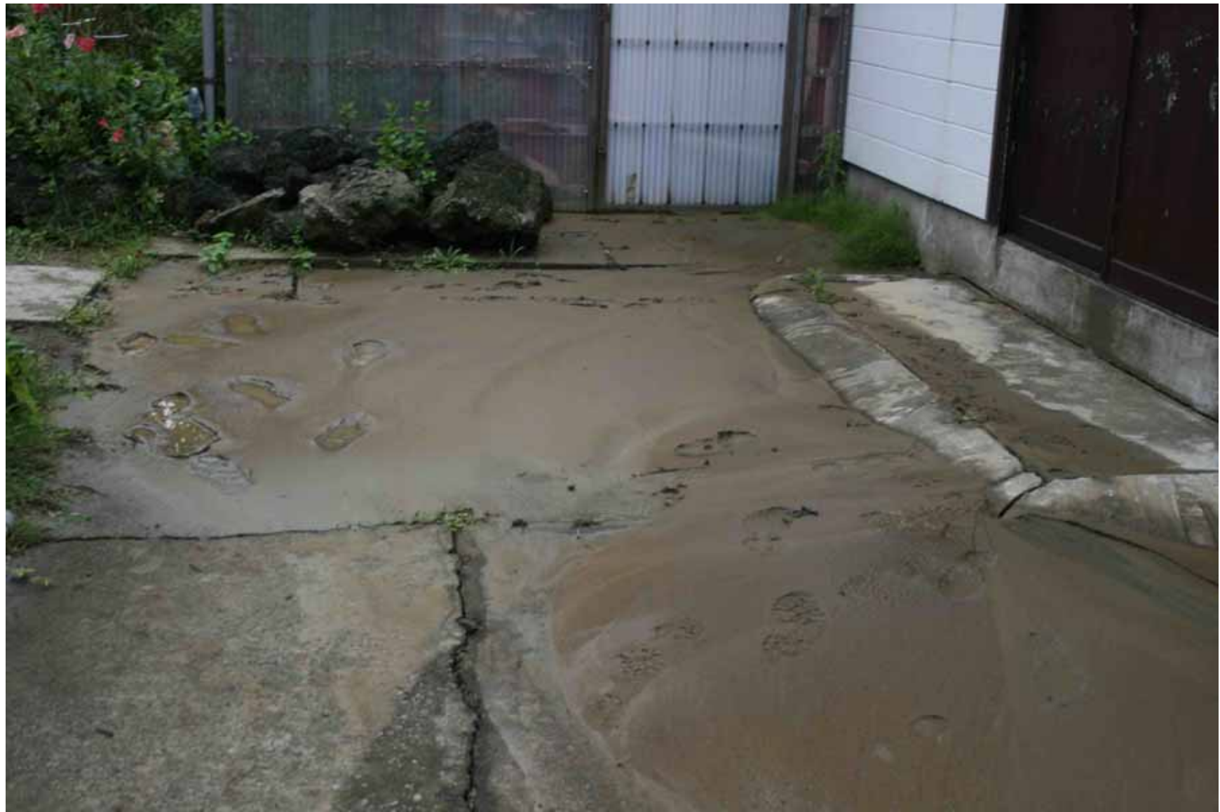
写真33 同上(柏崎市橋場町)、民家の玄関先の噴砂
