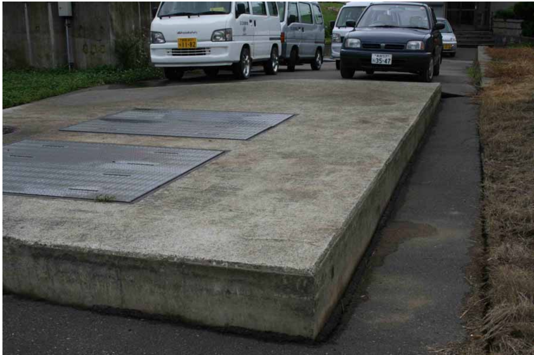
写真35 同上(柏崎市橋場町)、鯖石川左岸堤内法下道路の地中構造物と路面の段差・・・ 地中構造物が浮き上がったか、道路が沈下したかに関し、構造物基礎の調査要
