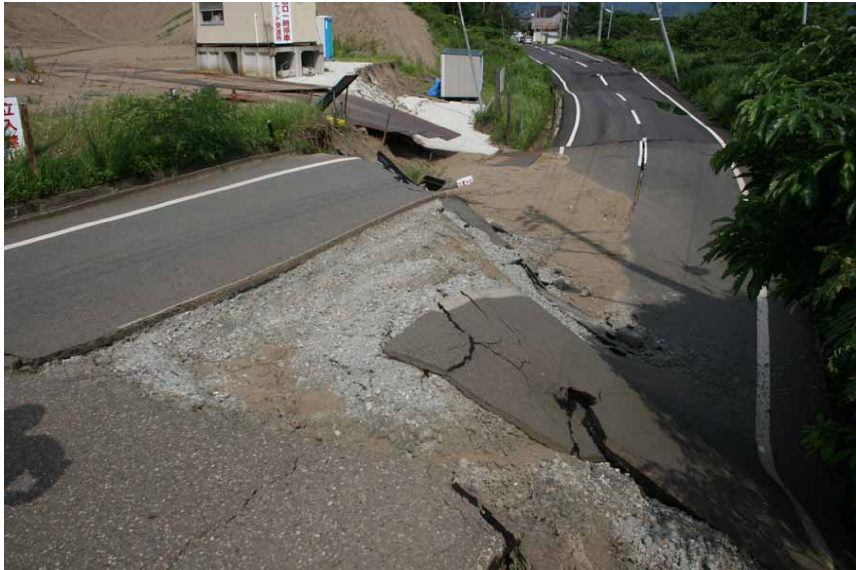
写真38 クリーンセンター裏手、砂取場と鯖石川右岸との間の地すべり
