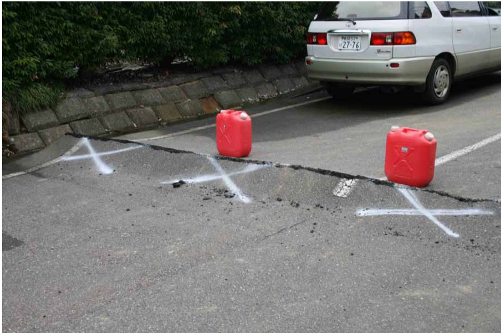
写真34 同上(柏崎市橋場町)、道路舗装の浪打現象
