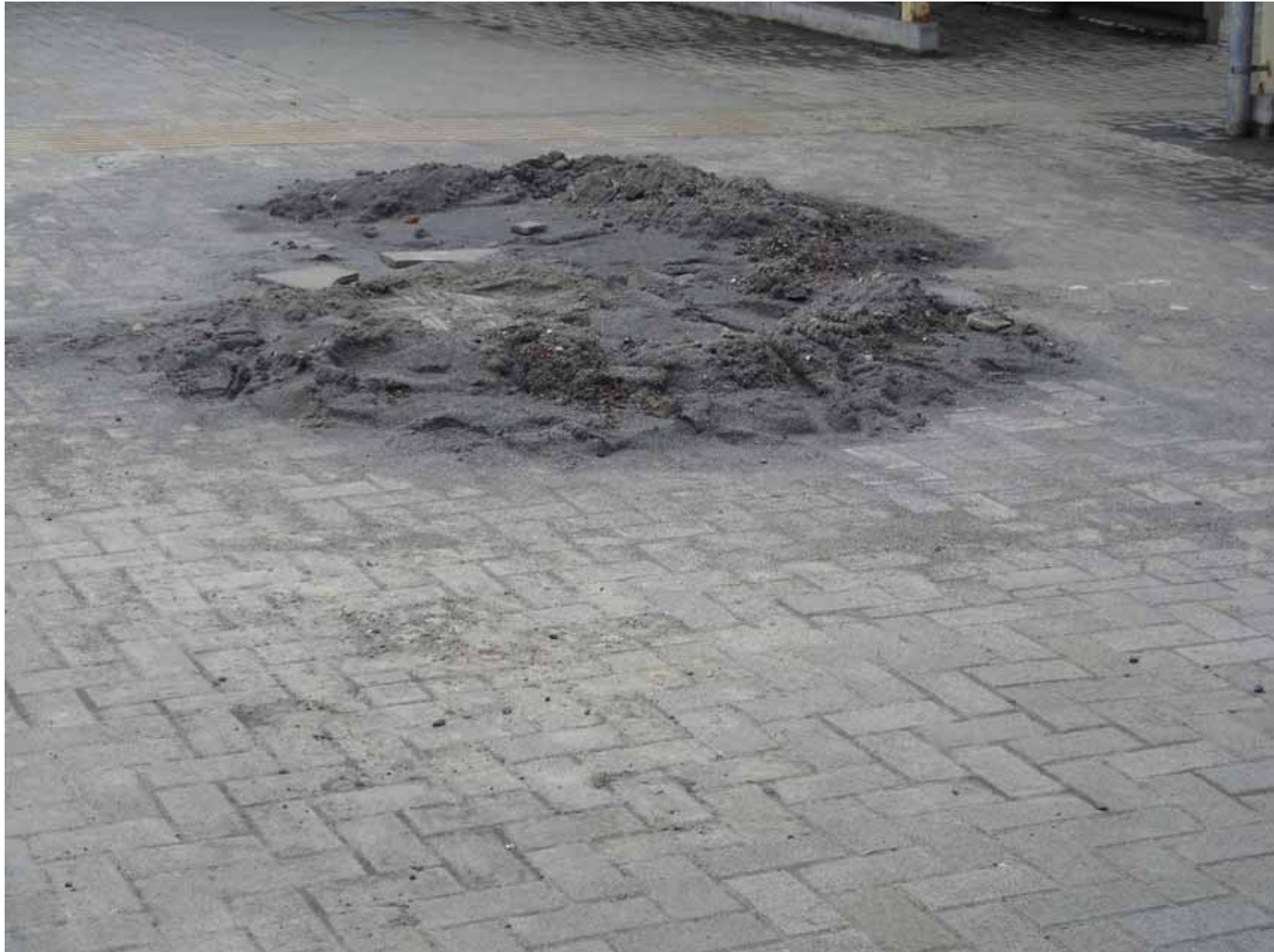
写真18 柏崎駅前の液状化による噴砂
