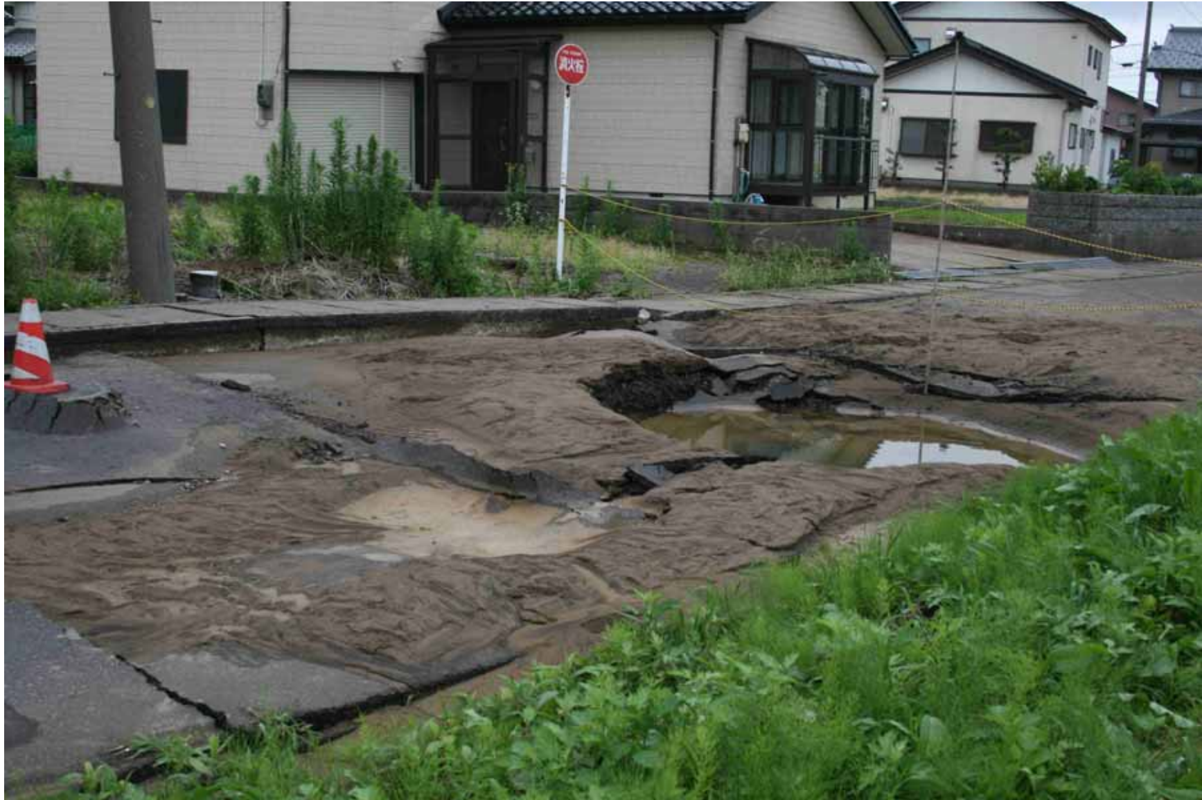
写真20 柏崎市橋場町、液状化によって出来た道路のクレーター
