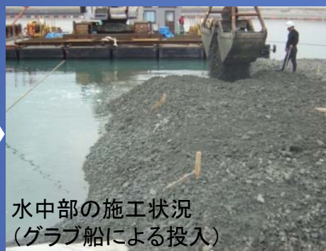
脱水処理土による海洋築堤の現地試験施工の状況
