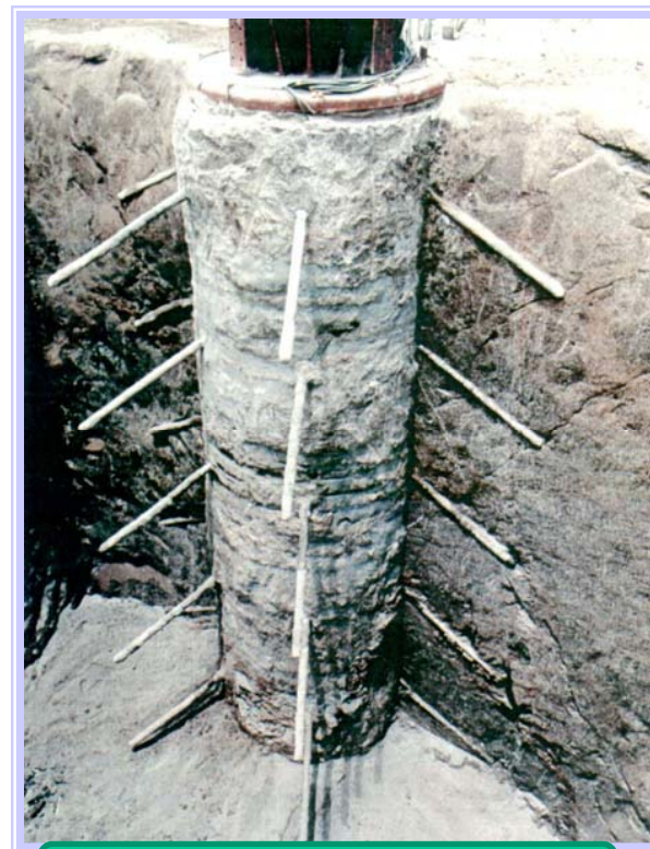
地盤補強型基礎工法
