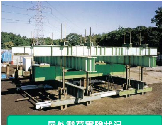
屋外載荷実験状況
