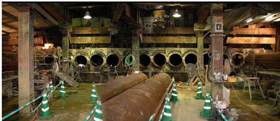
①水平部パイプルーフ工
