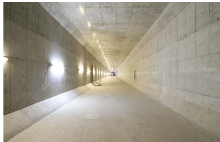
④躯体工完成
