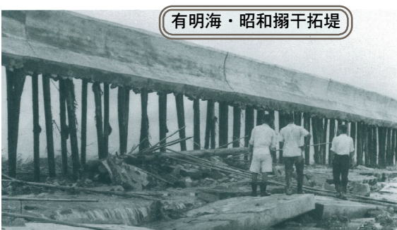
築造35年後の台風により洗掘露出した防波堤パラベットの木杭基礎
