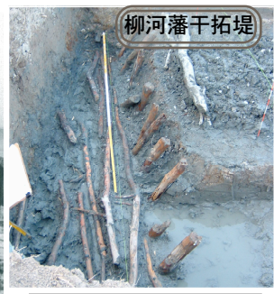
17世紀中頃築造された干拓堤防基礎(堤高6m)
