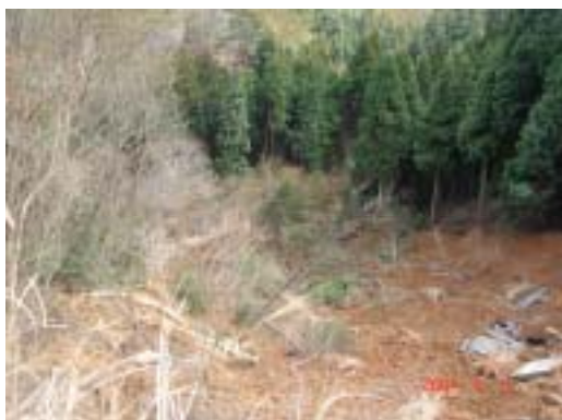
図-10 地点2)では150m程度の長距離流動が起き、下の沢を埋めて河道閉塞を起こした
