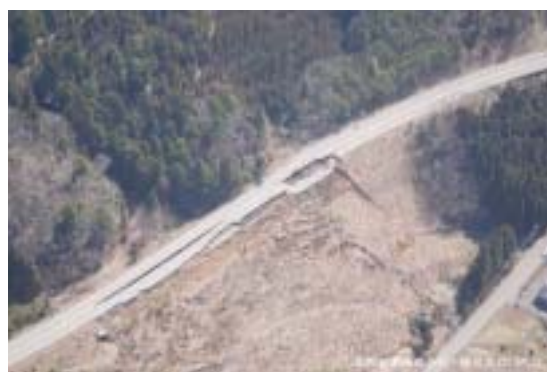
図-4 地点4)横田料金所南3km(国際航業 HP)
