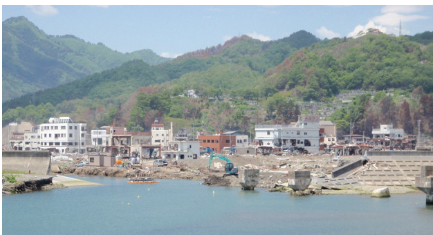
図-13 堤防破堤部の全景
