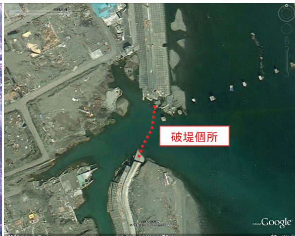
(b) 破堤後（2011年4月）
