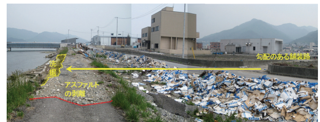
図-9 堤外側道路からの引き波の流入による洗掘
