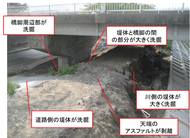
図-10 佐野橋右岸橋脚部の被災状況
