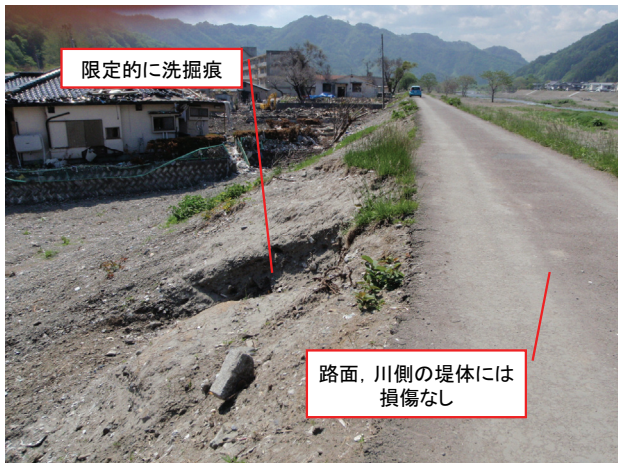
図-15 大槌川右岸（河口から約 1.6km）の法面被害
