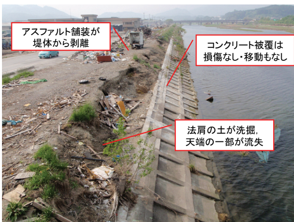
図-8 盛川右岸（河口から約1km地点）での洗掘被害
