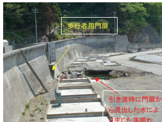
図-15 綾里川河口付近の海岸堤防
