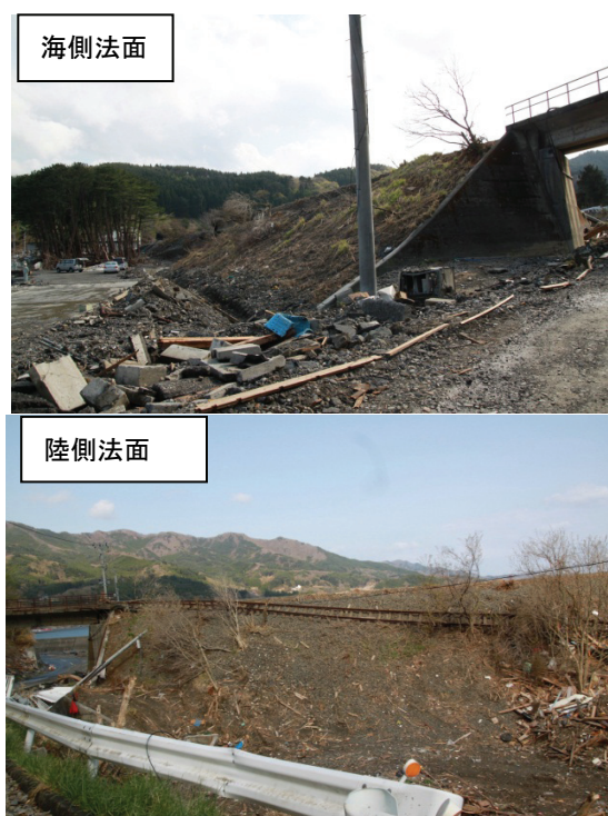
図-20 北側盛土の被災状況
