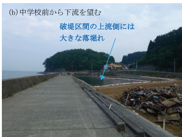
図-3 気仙川河口付近右岸堤防
