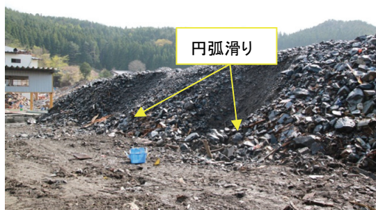
図-17 泊地区鉄道盛土（北側）の被災状況
