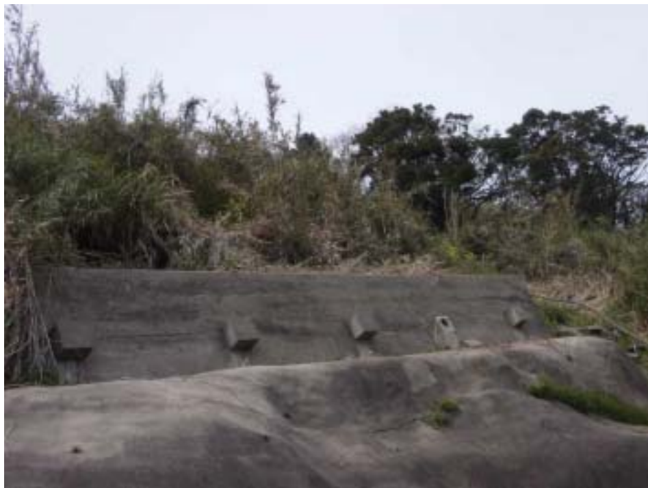
アンカー付擁壁
