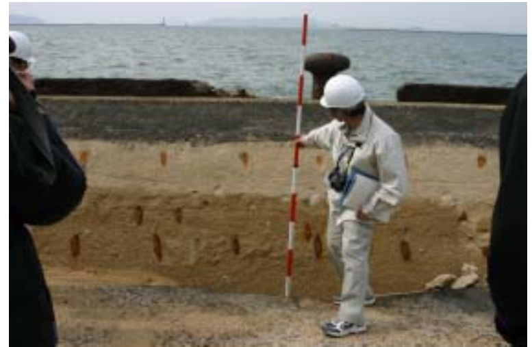
エプロン部の沈下
