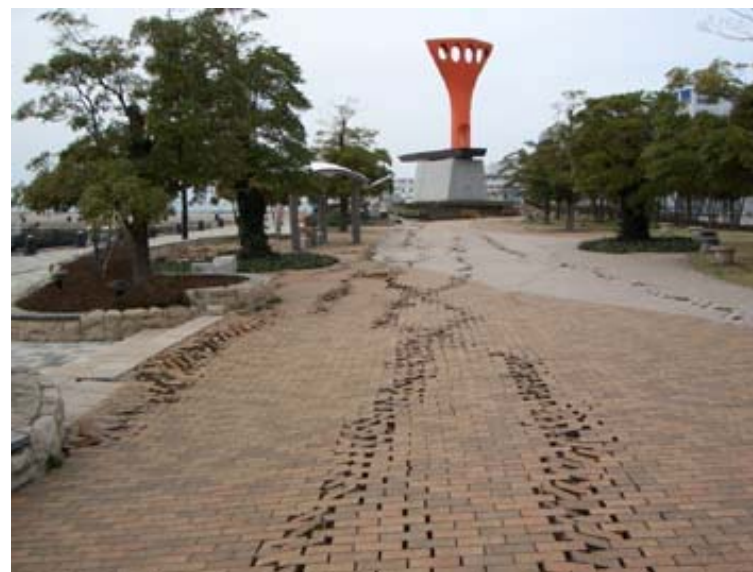
地割れの状況
