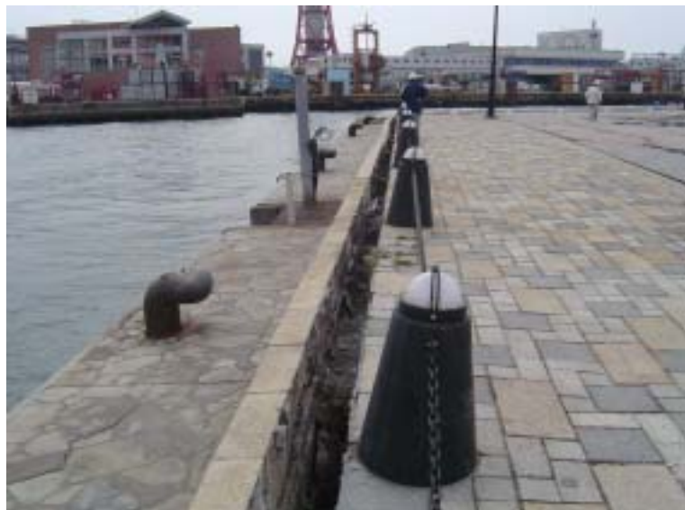
L型ブロック式岸壁のはらみだし
