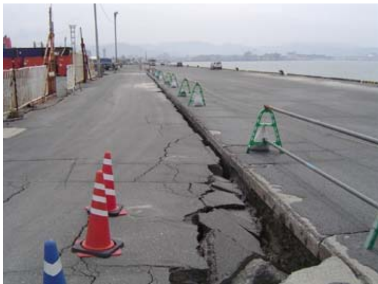
控え矢板式岸壁背後の段差
