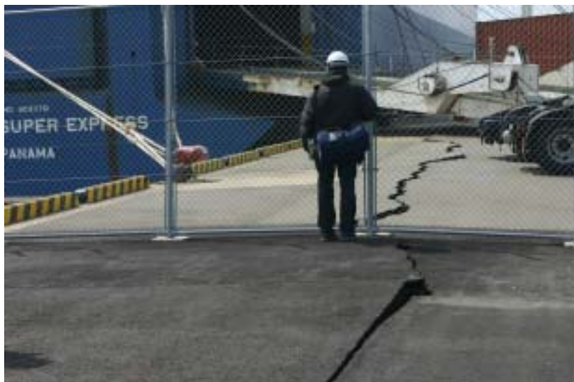
岸壁(-11m): ケーソン岸壁
