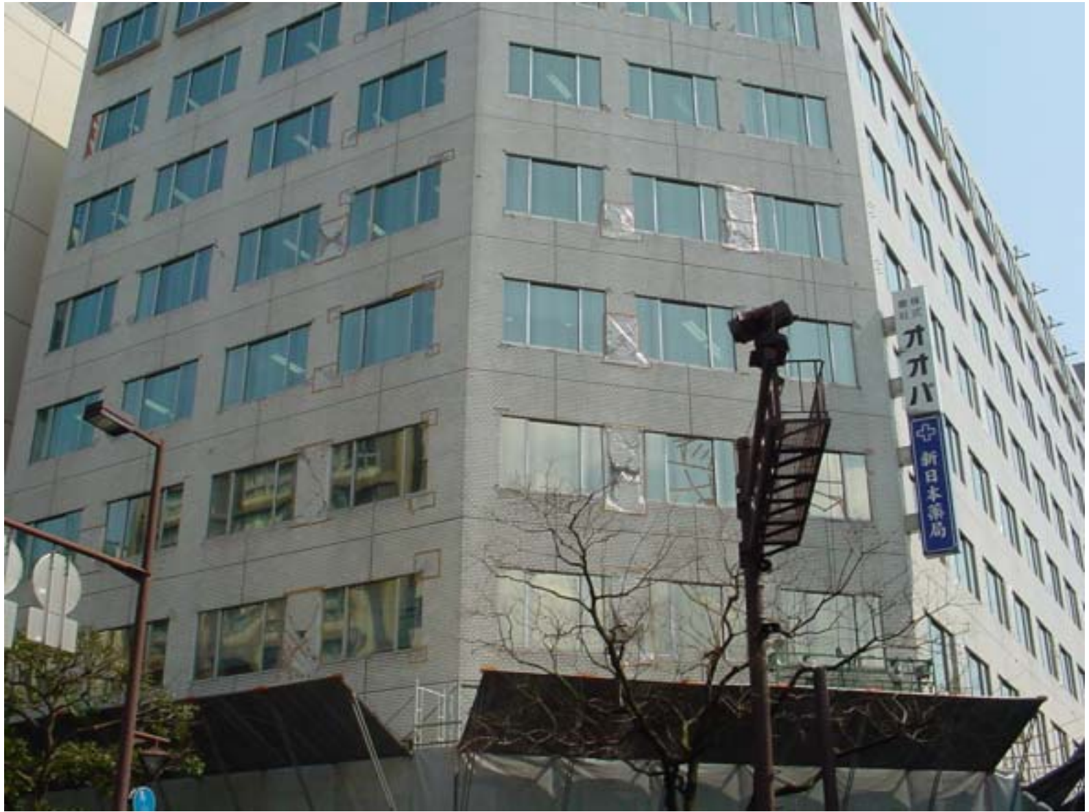
構造物被害状況
