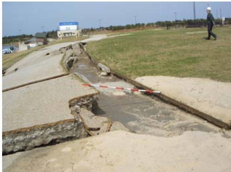
公園内歩道のずれ
