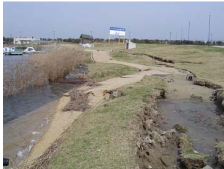
かも池周りの被害状況
