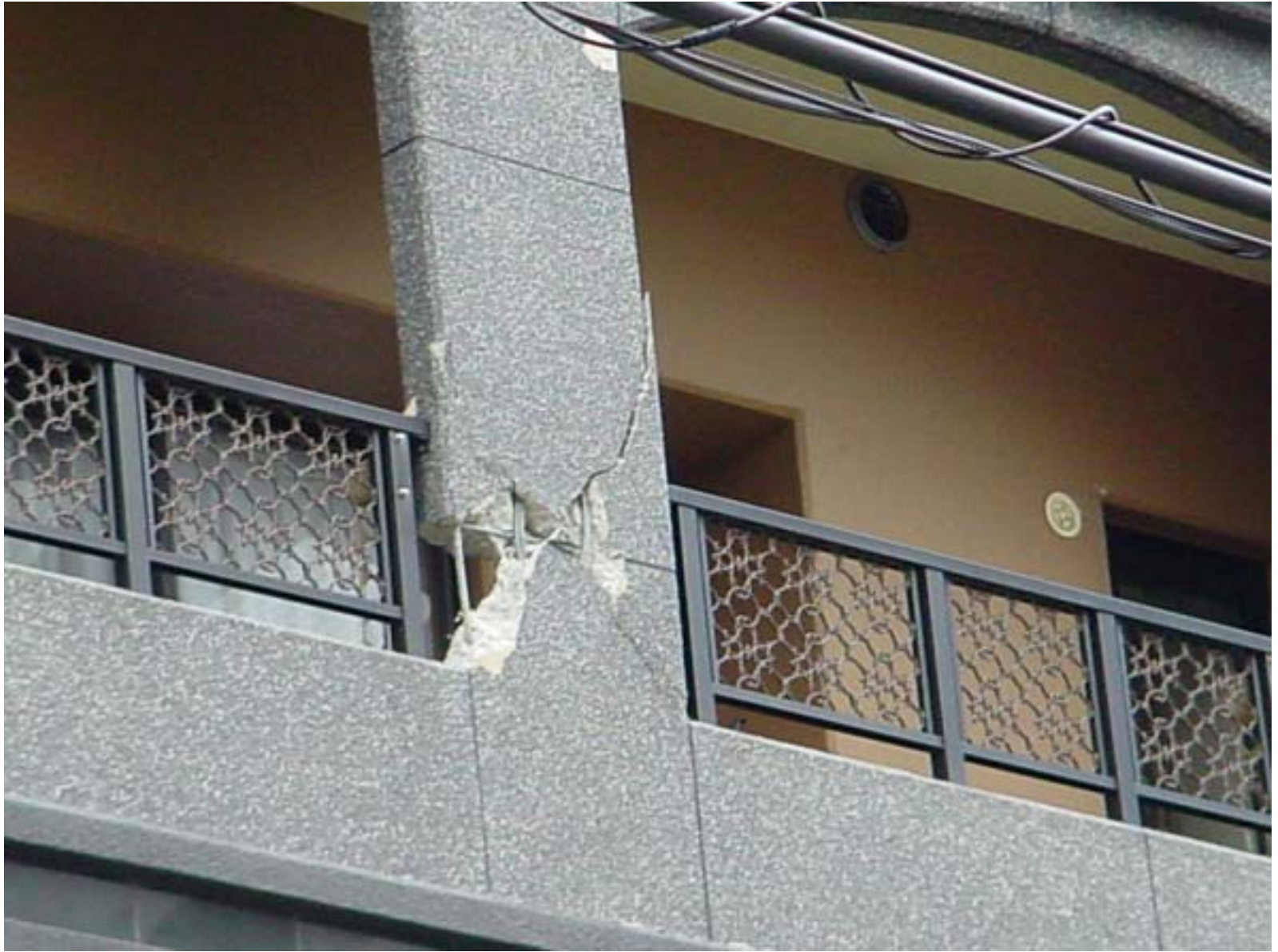
構造物被害状況
