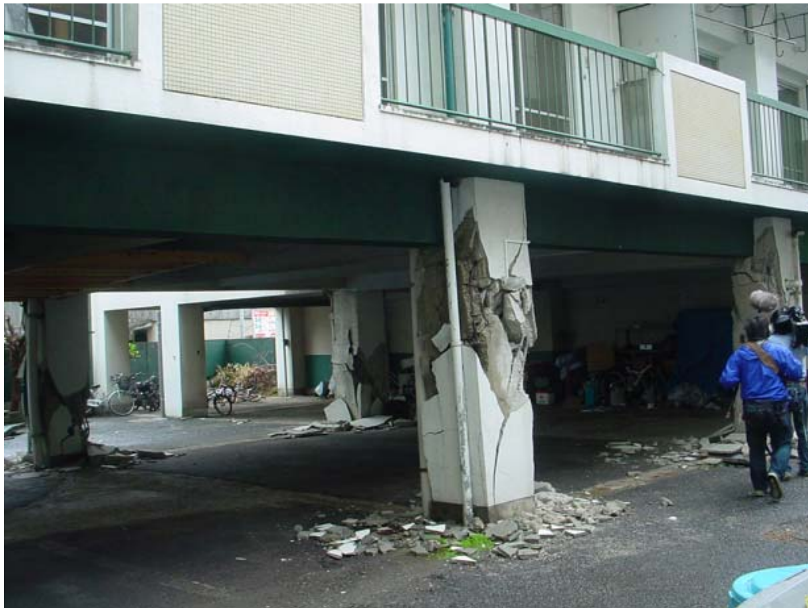
構造物被害状況
