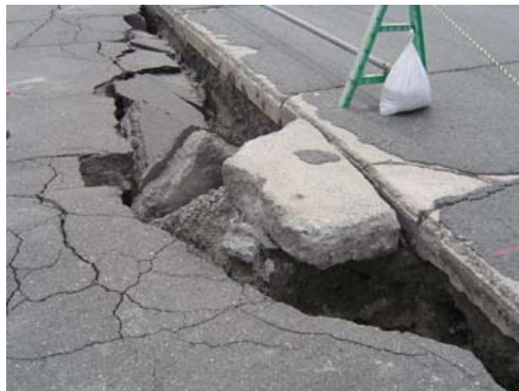
暗渠配水管の破断
