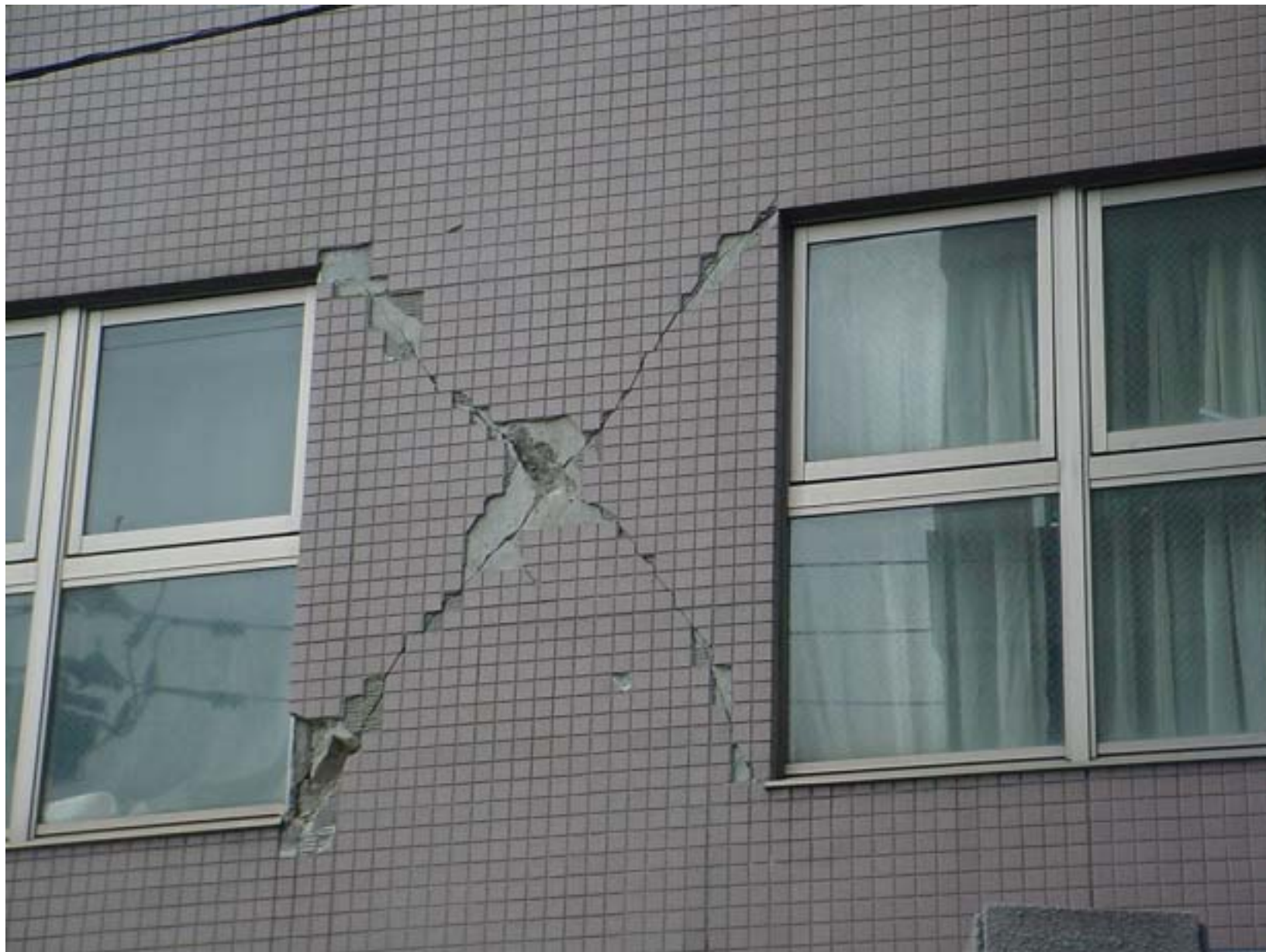
構造物被害状況
