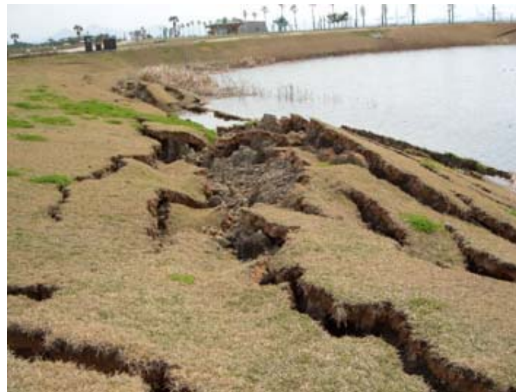
かも池周りの地割れ
