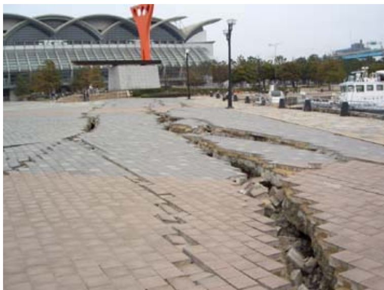
地割れの状況
