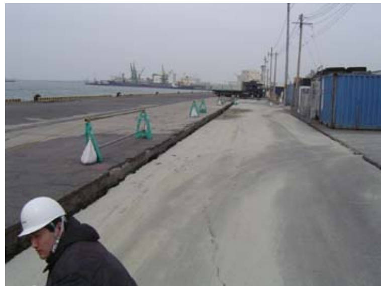
段差と噴砂跡の様子
