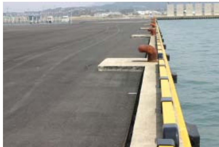
岸壁(-7.5m): L型ブロック
