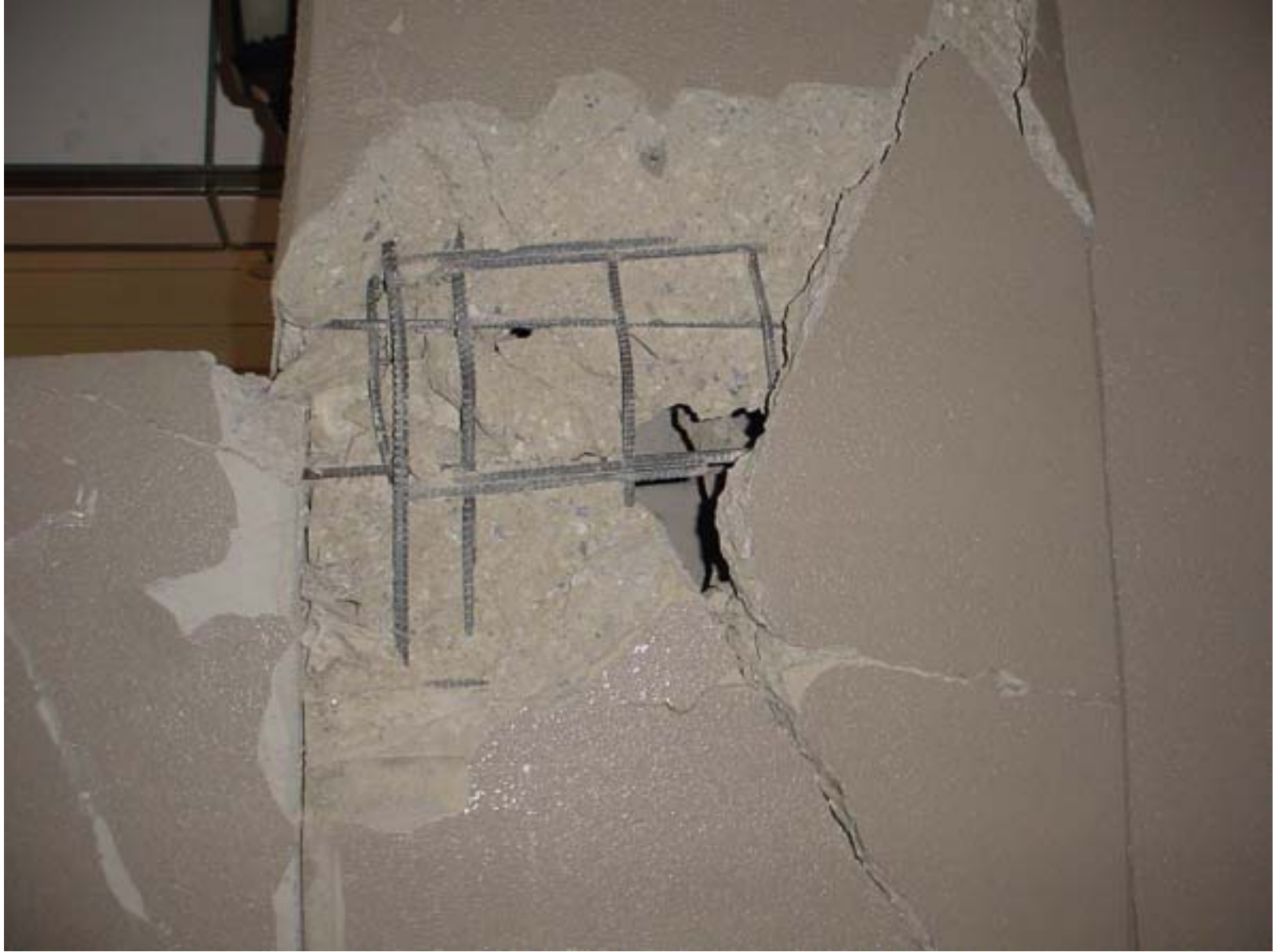
構造物被害状況
