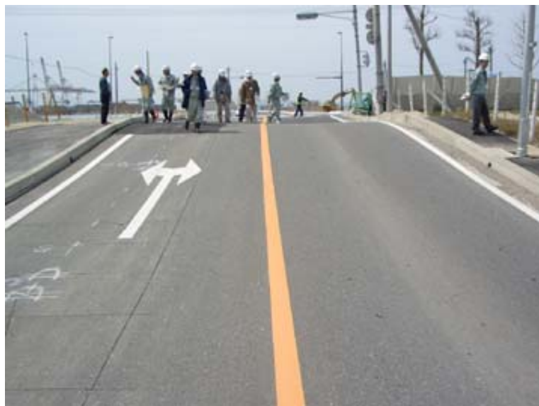
路面隆起(1m程度)の状況
