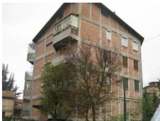
写真-99 4階建てRC造集合住宅
