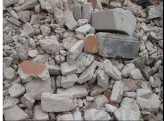
写真-32 崩壊した組積材と仕上の残骸
