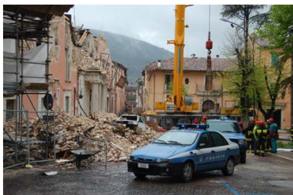
写真-160 建物の倒壊により埋没されたり通行不能となった車両 (ラクイラ旧市街地中心部)
