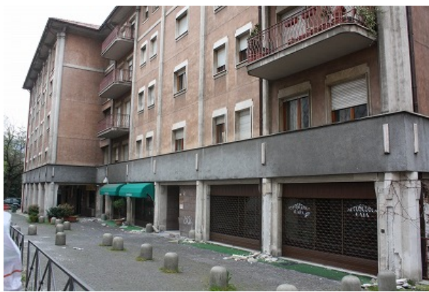
写真-53 EXPJで繋がるホテル 損傷小(9, 10)
