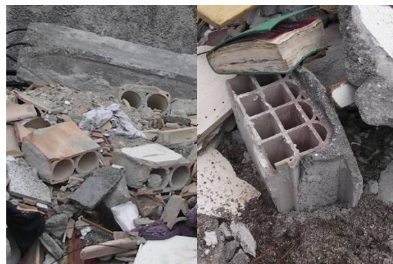
写真-56 空洞煉瓦(1)
