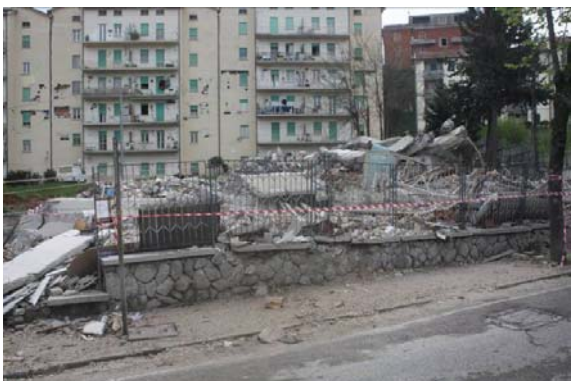
写真-55 倒壊した建物(1)
