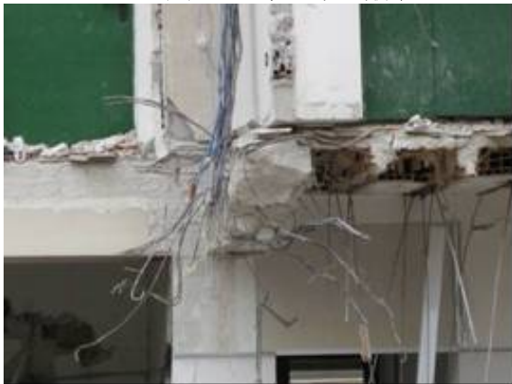
写真-71 2階梁とスラブ
