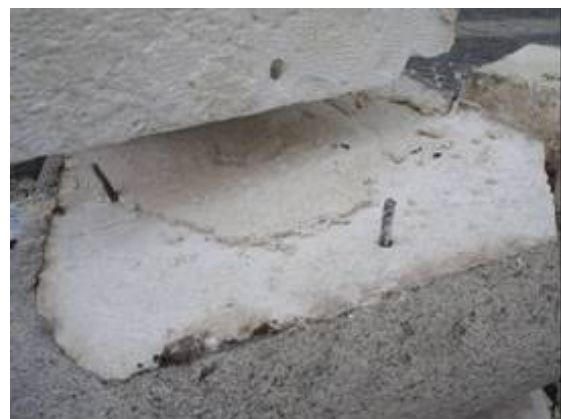
写真-22 ダボ筋による接合
