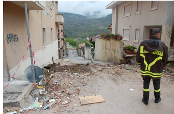
写真-11 応急的に埋め立てられた写真-10 と同一箇所
