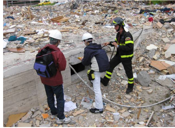
写真-58 シュミットハンマー調査／ 建物基礎部分にて(1)
