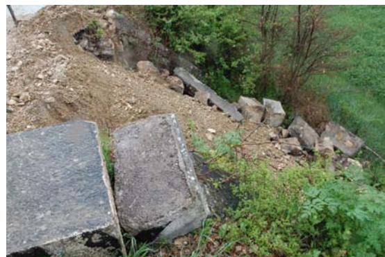
写真-146 散在する石造アーチ主構部材
