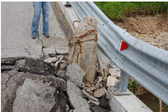
写真-135 床版上に突出した橋脚頭部
