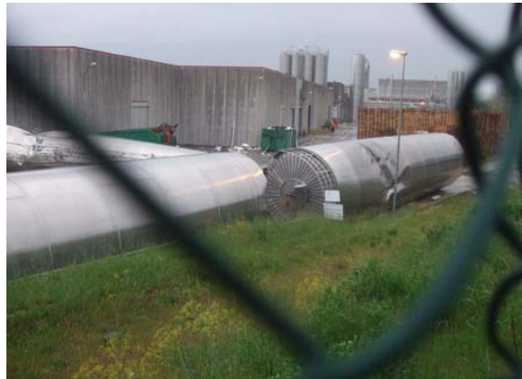
写真-164 バーナーで切断されたサイロ
