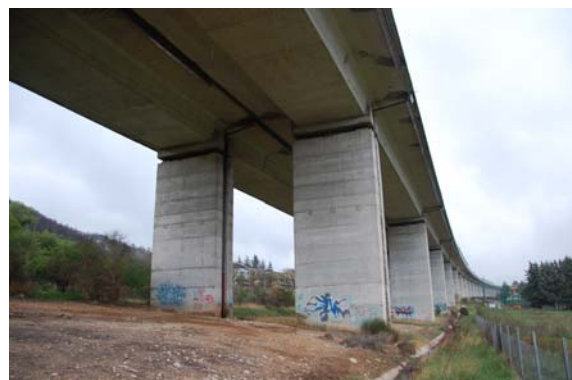
写真-150 A24 の高架橋
