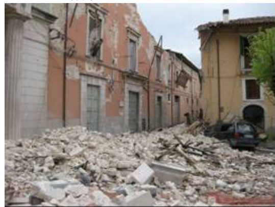
写真-36 落下した外壁により車が下敷
