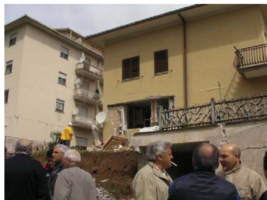
写真-120 盛土崩壊の様子
