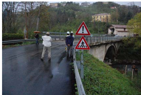
写真-147 石造アーチ橋取り付け盛土の沈下補修 (SR615)
