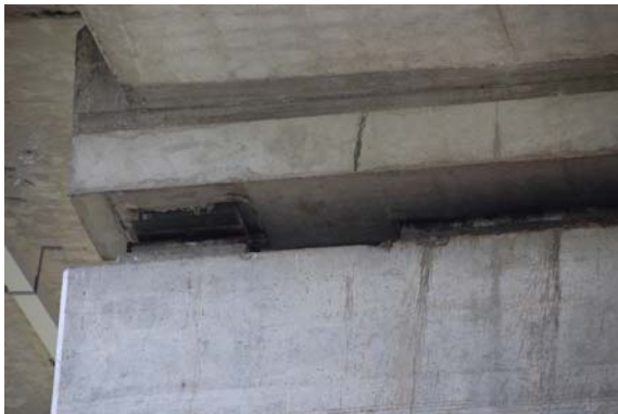
写真-155 桁中間部の支持状態 (積層ゴム支承)
