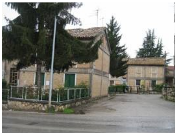
写真-96 低層RC造住宅
