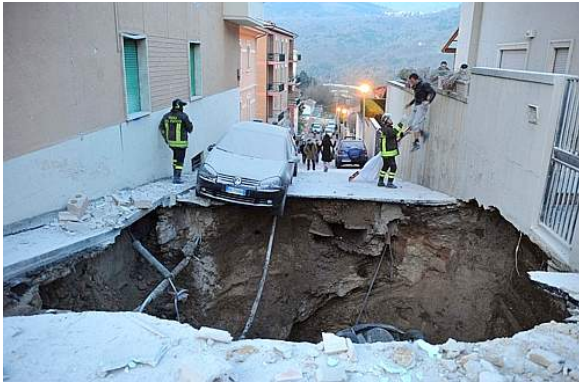
写真-10 自然空洞の崩壊による路面陥没 (web による)
