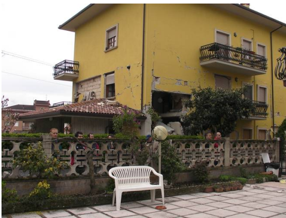
写真-109 平均的なRC建物
