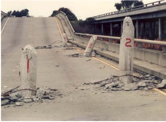
写真-139 パンチングシェアーにより 床版上に突き出した パイルベント橋脚頭部
