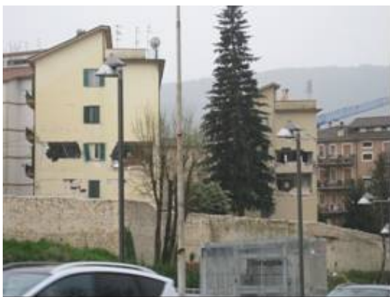
写真-95 中間階の組積壁の崩落が目立つ
