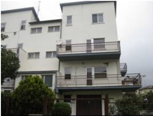
写真-91 4階建てRC住宅
