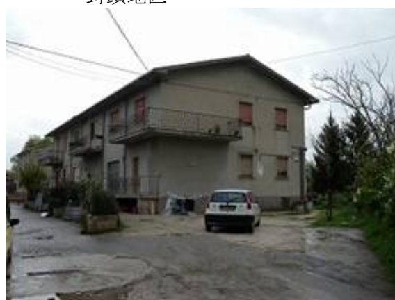
写真-88 崩壊した組積造（写真-87）に隣接する建物
