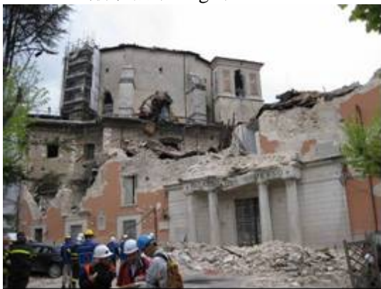
写真-35 組積造の2階部分が崩壊
