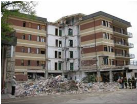
写真-69 学生寮の崩壊
