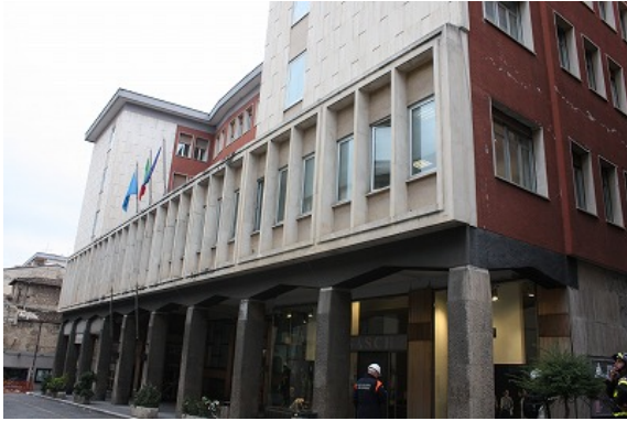
写真-39 1階部分がピロティ形式の建物(2)
