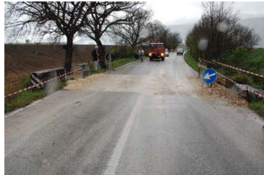
写真-145 石灰岩質の砕石投入により応急復旧された路面
