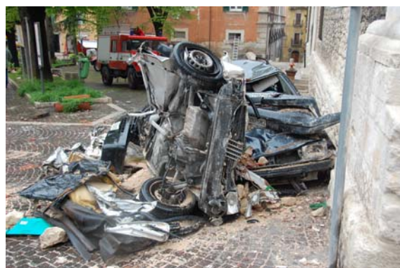
写真-161 建物の倒壊により埋没された車両 (ラクイラ旧市街地中心部)
