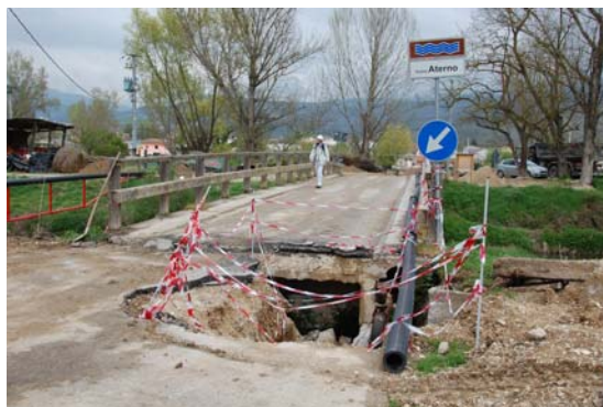
写真-143 水道管復旧のため掘削された 取り付け盛土部
