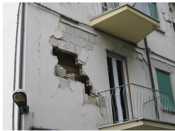
写真-68 空洞煉瓦壁を2重にして設置(5)
