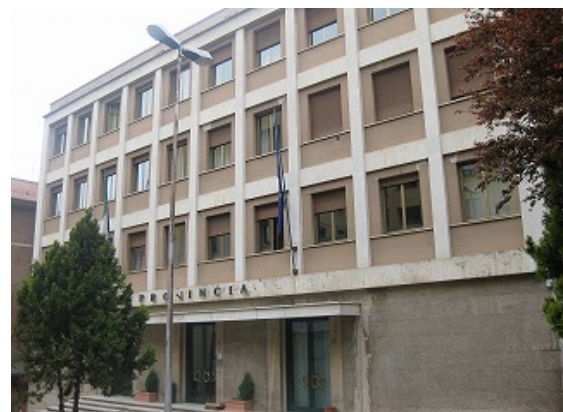
写真-54 行政関係の建物 損傷なし(11)
