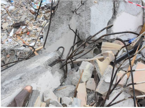
写真-57 RC 躯体に用いられている丸鋼(1)
