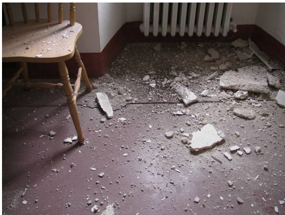
写真-125 床のひび割れ
