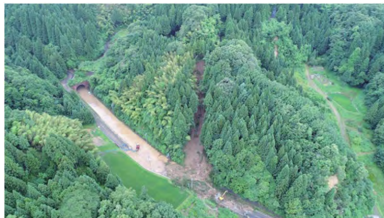
写真2.3-2 崩壊土砂がトンネル内に流入している状況 5)
