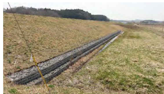
川裏側 には変 状なし
