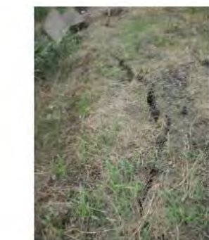
R6 右岸 11.0k 被災 (亀裂)
