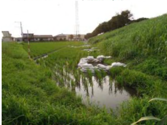
16.1k 付近の堤防法尻より下流方向撮影（応急処置後）
