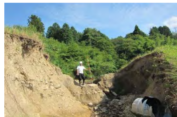
写真4.2.1 越流によるため池の破堤 寺田池(東広島市) (平成30年7月豪雨)
