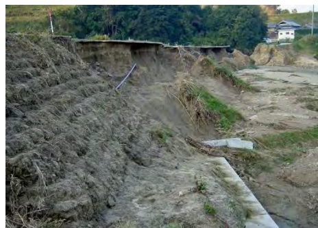
写真4.6.2 越流による堤体の侵食
